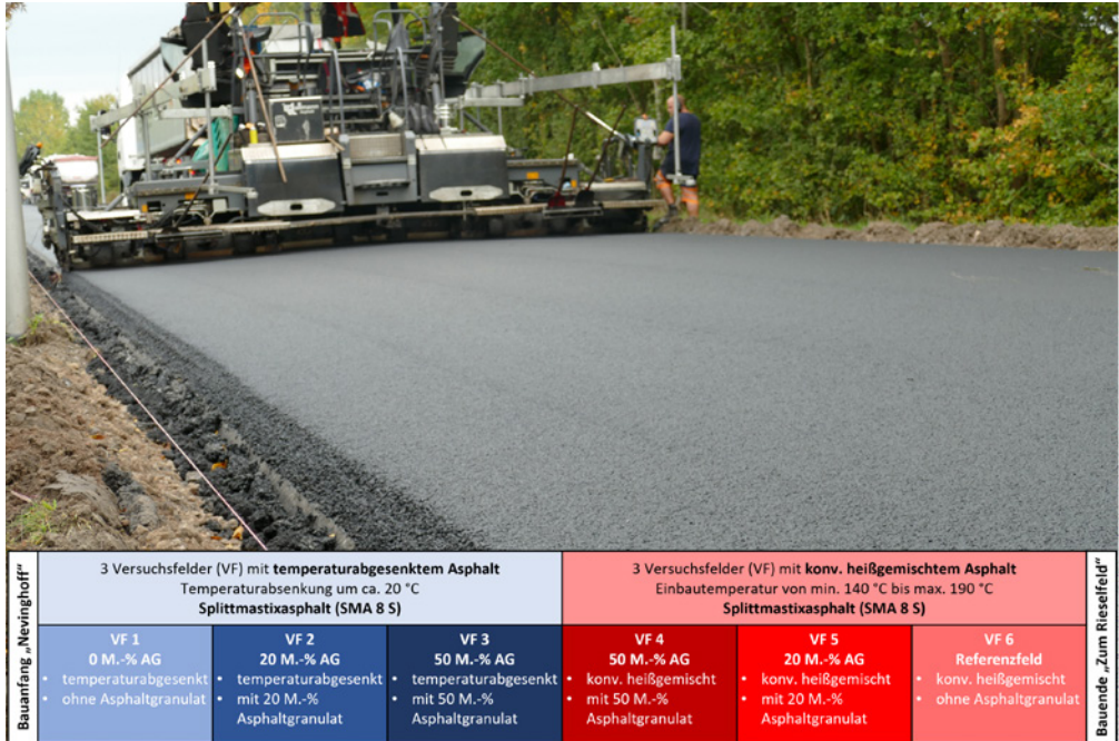
Abbildung 1: Bau der Versuchsstrecke mit sechs Versuchsfelder
