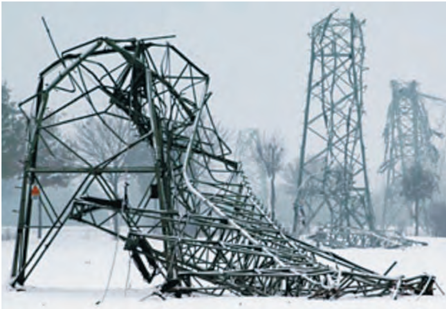
Abb. 1: Eingestürzte Strommasten im Münsterland.
