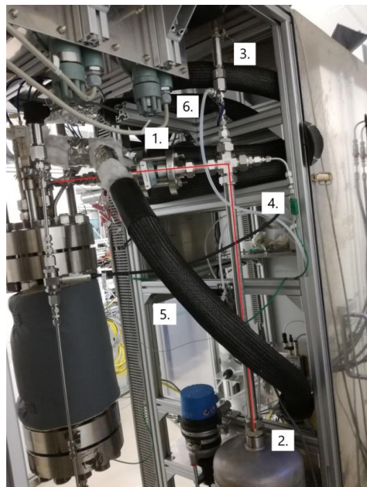
Abbildung 18: Die Druckausgleichsleitung, in rot hervorgehoben mit 1. Berstscheibe, 2. Druckausgleichsbehälter, 3. Drucksensor PI-3, 4. Thermoelement TI-21, 5. 1 m-Heizschlauch, 6. Teflonleitung zur Entfernung des Luftsauerstoffs
