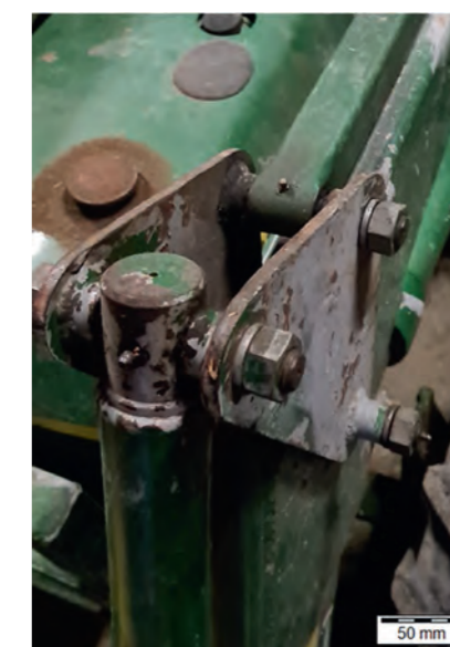
Bild 4: Eingebautes geschweißtes Dreigelenk
