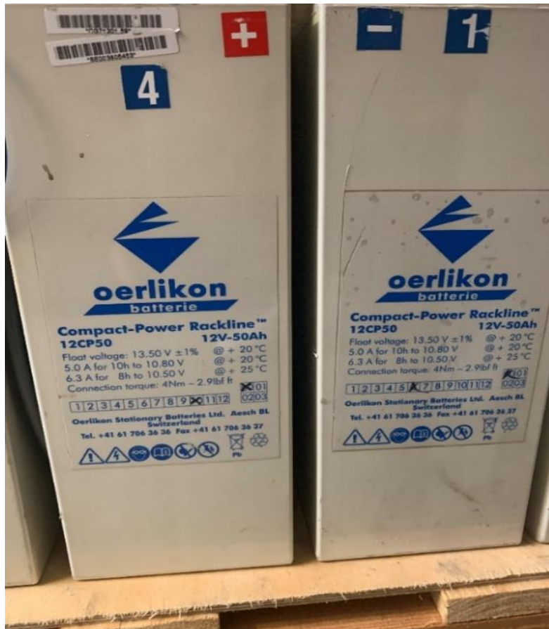
Abbildung 2-13: Außenansicht der Oerlikon 12CP50 Akkumulatoren
