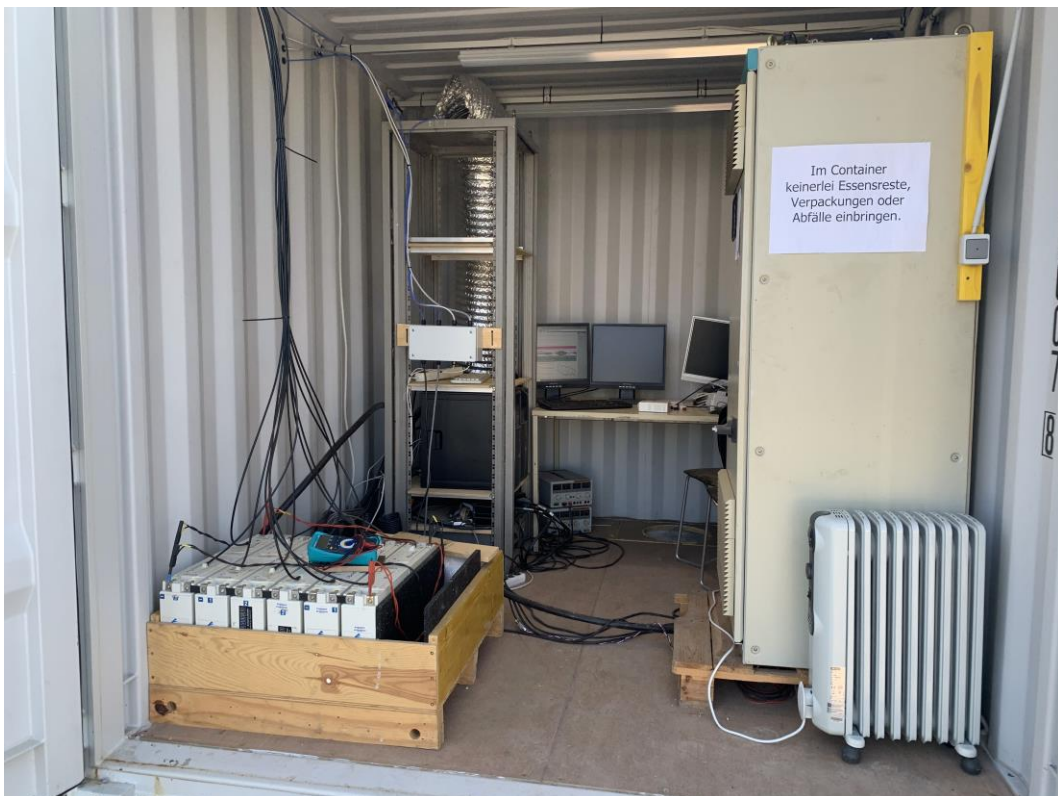
Abbildung 6-11: Verbau der Stromversorgung vorne links
