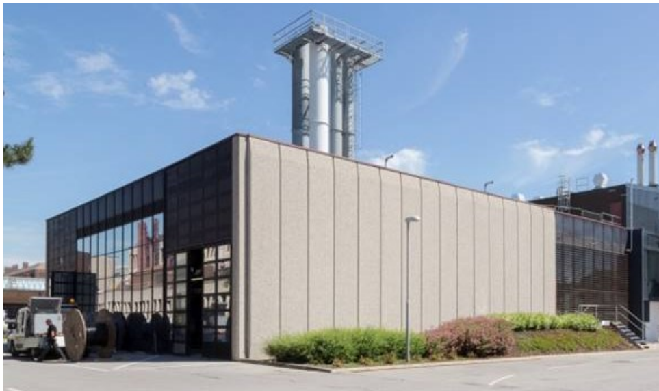
Abbildung 3-3: Energiezentrale. (Quelle: Takeda.)
