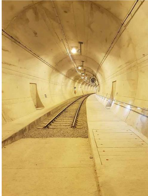
Abbildung 2.26: EBT-W mit einem installierten Strahlventilator
