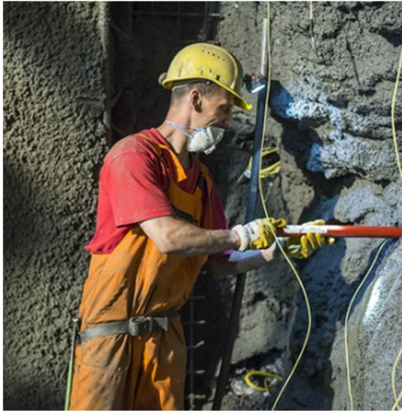
Abbildung 9 - Laden der Bohrlöcher [13]
