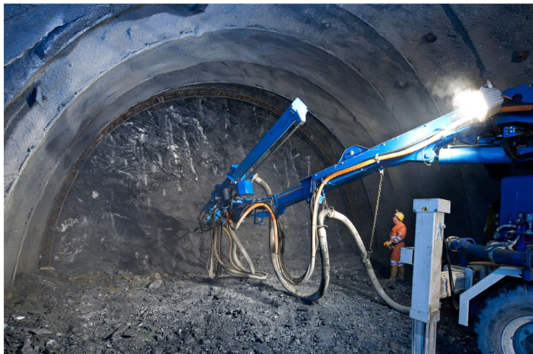
Abbildung 14 – Auftrag des Spritzbetons mittels Spritzbetonmanipulator [13]
