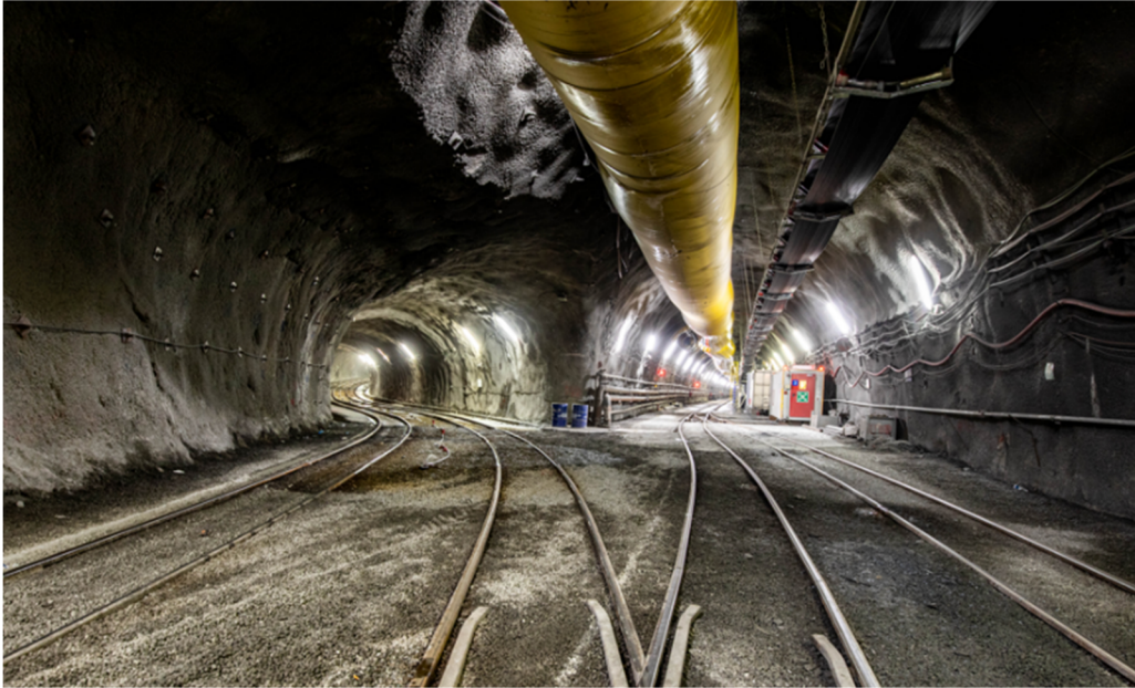
Abbildung 12 - Luttenleitung im Tunnelbau [13]
