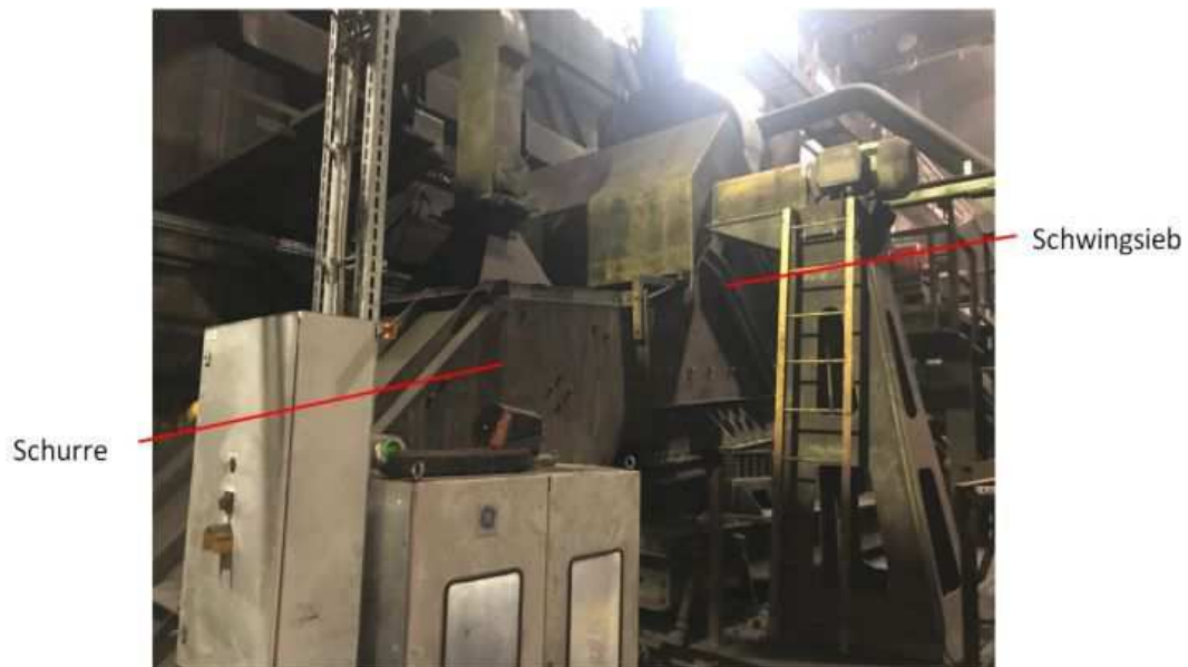
Abbildung 16: Schwingsieb mit der darauf folgenden Schurre
