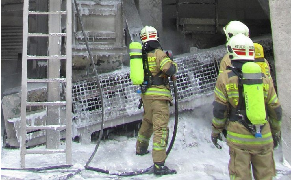
Abbildung 29 Brandbekämpfung eingehauster Förderer Quelle: FF Golling
