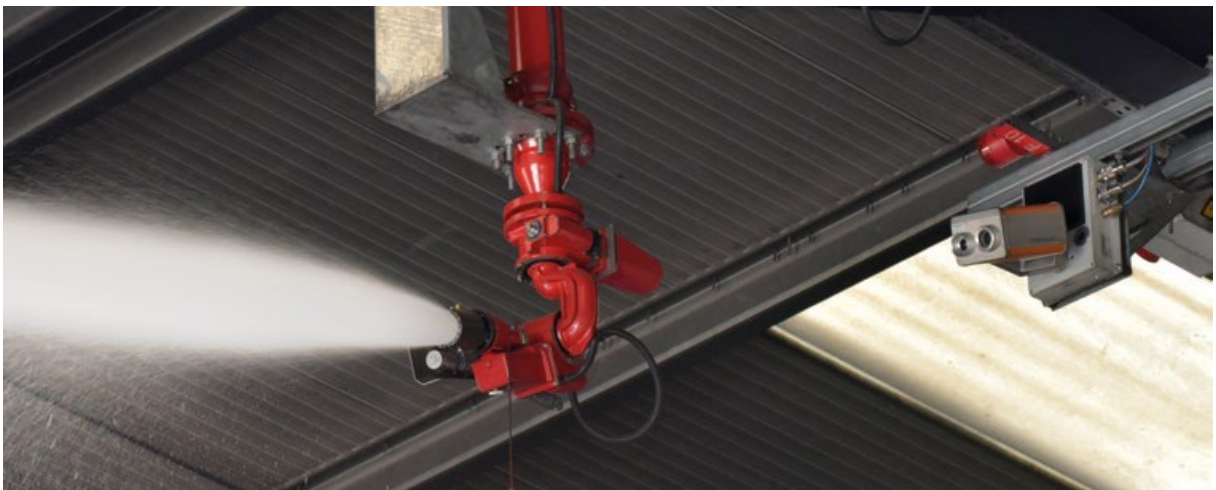
Abbildung 43 Zusammenspiel IR-Kamera und Löschmonitor Quelle: Rosenbauer
