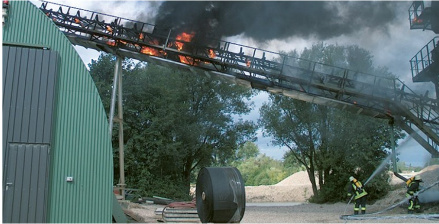
Abbildung 2 Brand einer Förderbrücke Quelle: BG RCI
