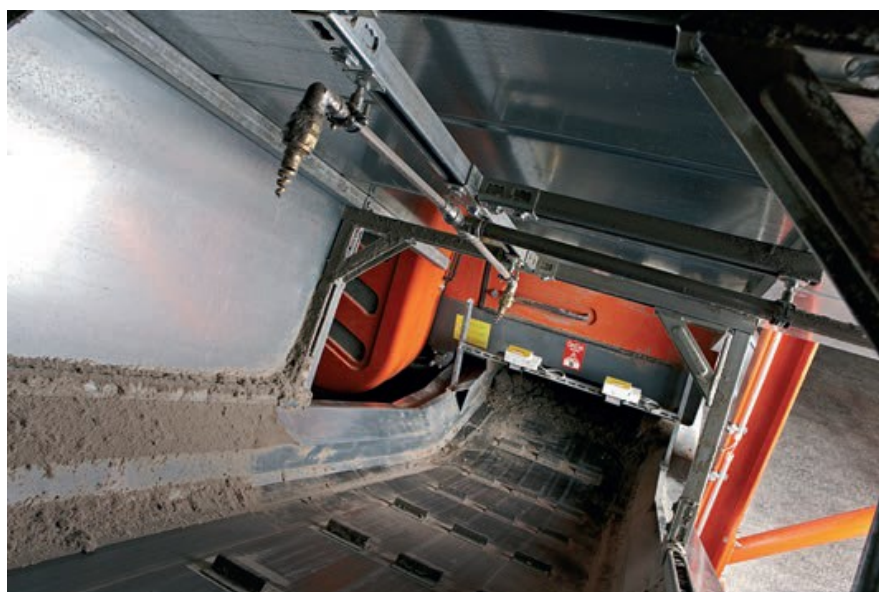
Abbildung 48 CAFS-Sprinklerdüsen Quelle: Rosenbauer
