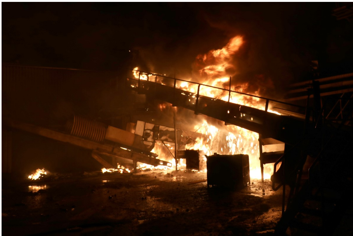
Abbildung 1 Brand einer Abfall-Förderanlage Quelle: FF Laxenburg
