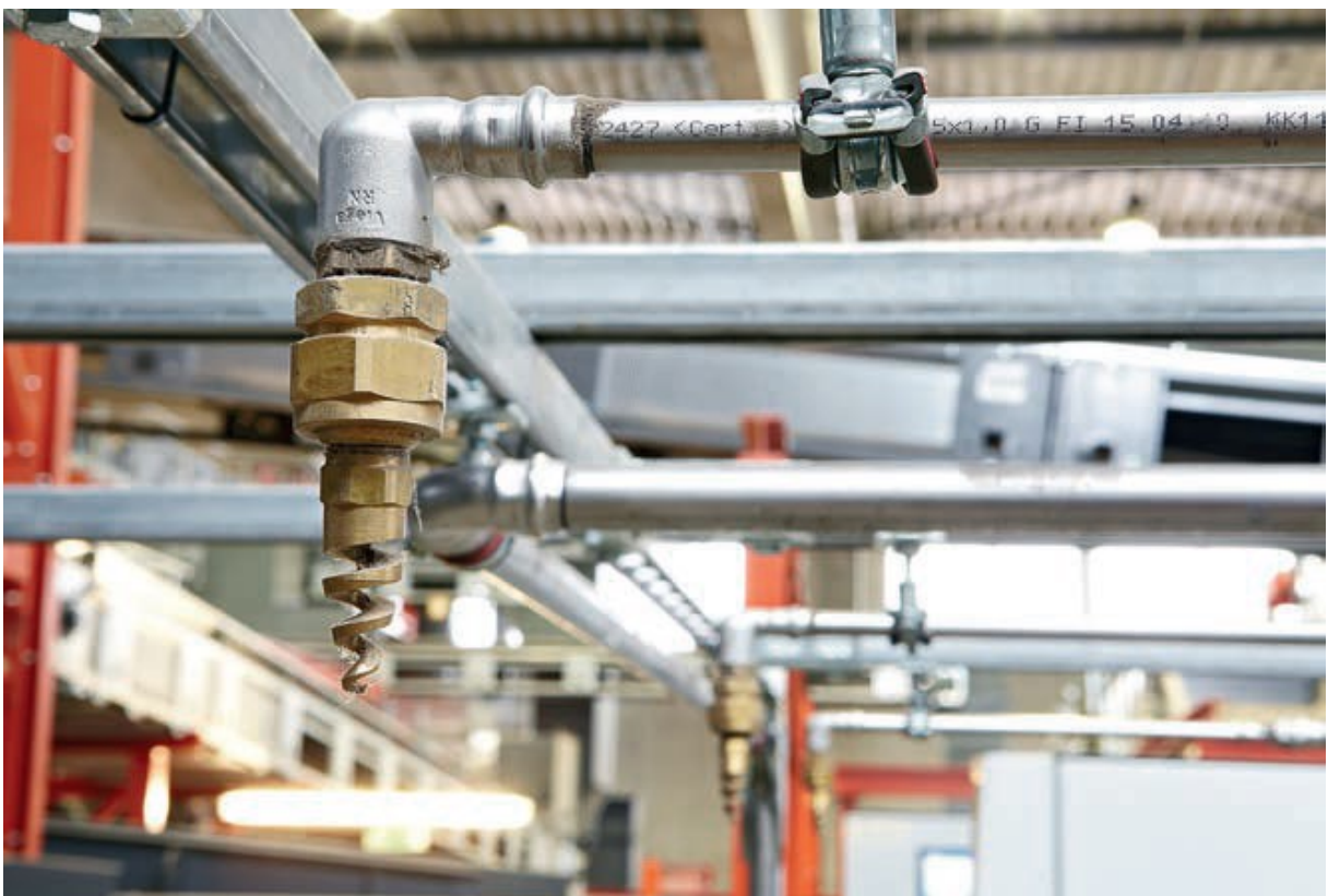
Abbildung 50 CAFS-Sprinklerdüse Quelle: Rosenbauer
