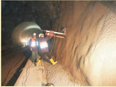
Kernbohrung im Tunnel
