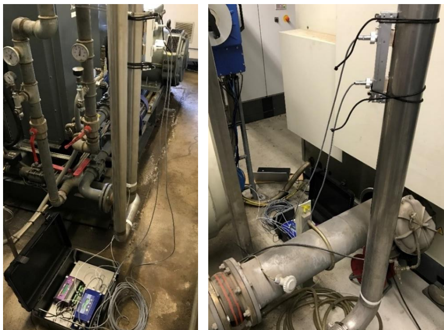
Abbildung 5.8 Messungen an den HDD-Anlagen: Atlas Copco links – LMF rechts
