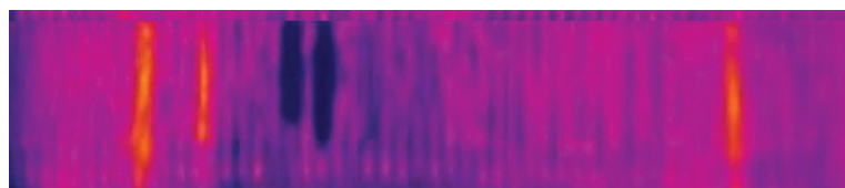
Abbildung 3-4: Darstellung einer Thermografie von Kurzschlüssen in einer Kupferraffinationselektrolyse
