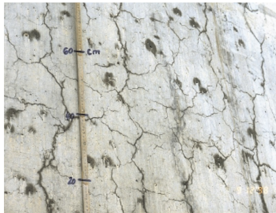
Abbildung 3: Beispiele für vernetzte Risse oder auch „Map Cracking“ a) An einem Brückenpfeiler SHRIMER 2005 b) Bauwerksaussenseite, KNAUTE 2008
