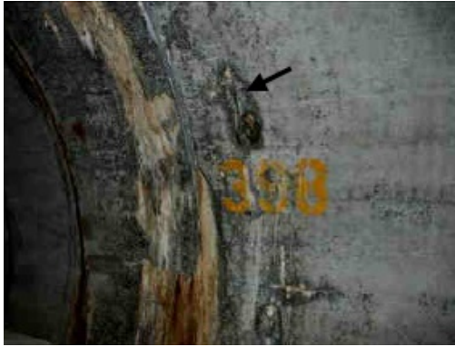
Abbildung 5: a) Gelprodukte an der Tunnelwand b) Feuteaustritte mit Gelprodukten an der Tunnelwand, FREYBURG & ERFURT 2007
