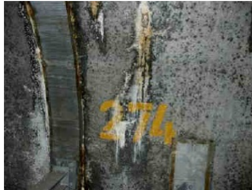
Abbildung 5: a) Gelprodukte an der Tunnelwand b) Feuteaustritte mit Gelprodukten an der Tunnelwand, FREYBURG & ERFURT 2007
