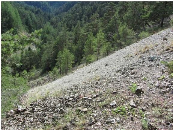
**Abb.28:** Halde im Nahbereich zu den Stollen S11, S83 und S21 mit mehreren eingezogenen Bermen zur Stabilisierung des Haldenkörpers. Talseitig (zur Straße) wird er durch eine Steinmauer abgegrenzt. Links hinten ist die große Halde an der orographisch linken Hangseite erkennbar. Blickrichtung Südwest.
