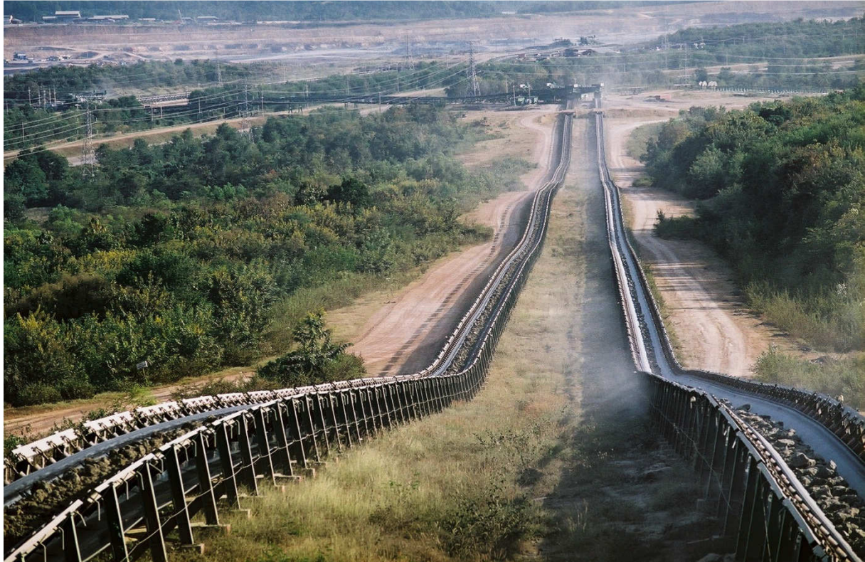
Abbildung 124: Ähnliche Anlage in Thailand (Mae Moh V)
