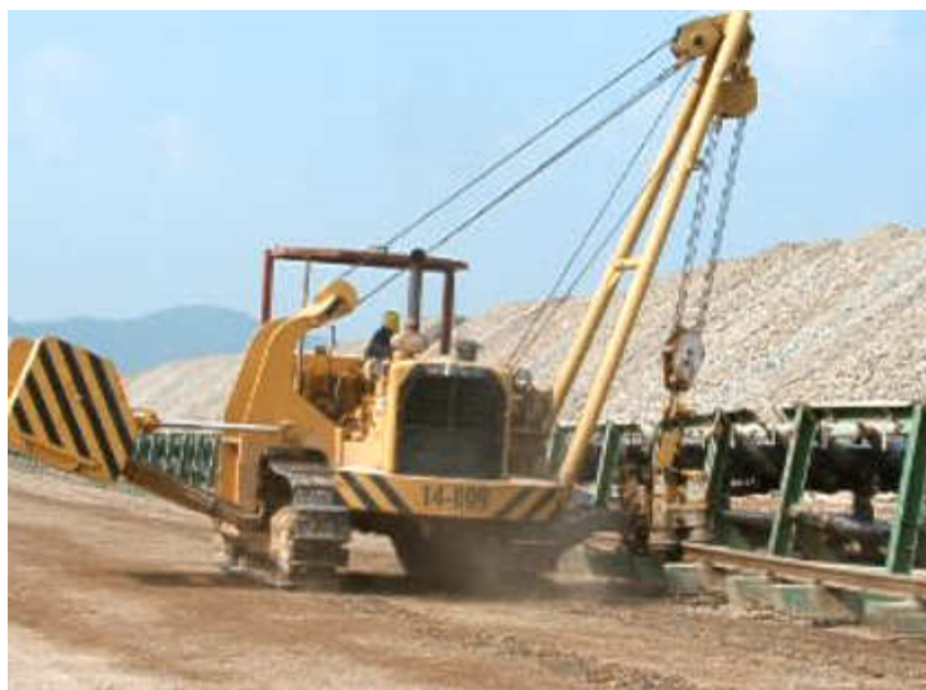
Abbildung 16: Rohrverlegemaschine, mit Spezialequipment
