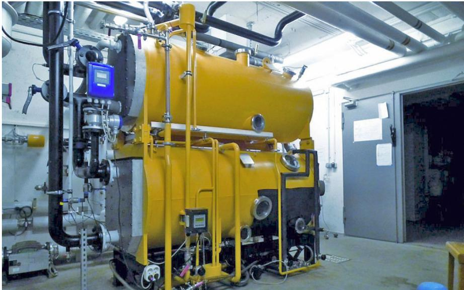
Abbildung 3.9: Absorptionskälteanlage für den kleineren Leistungsbereich [36]
