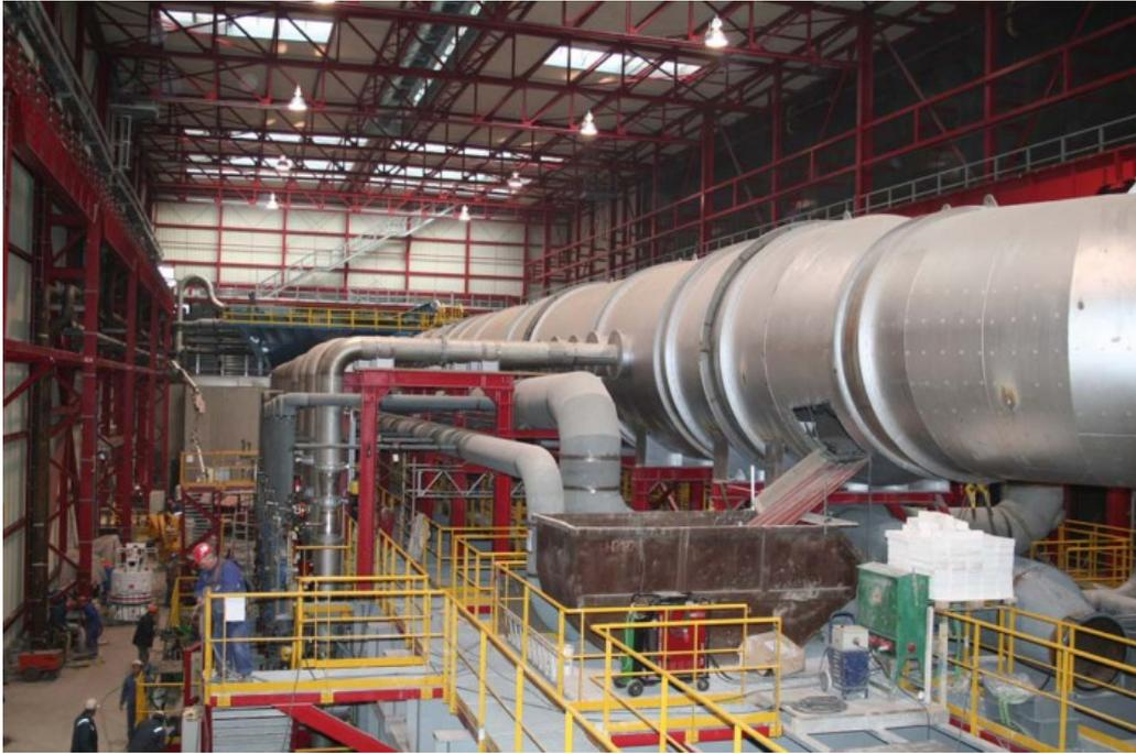
Abbildung 4.4: HBO-Verbrennungsluftleitungen während der Bauphase [41]
