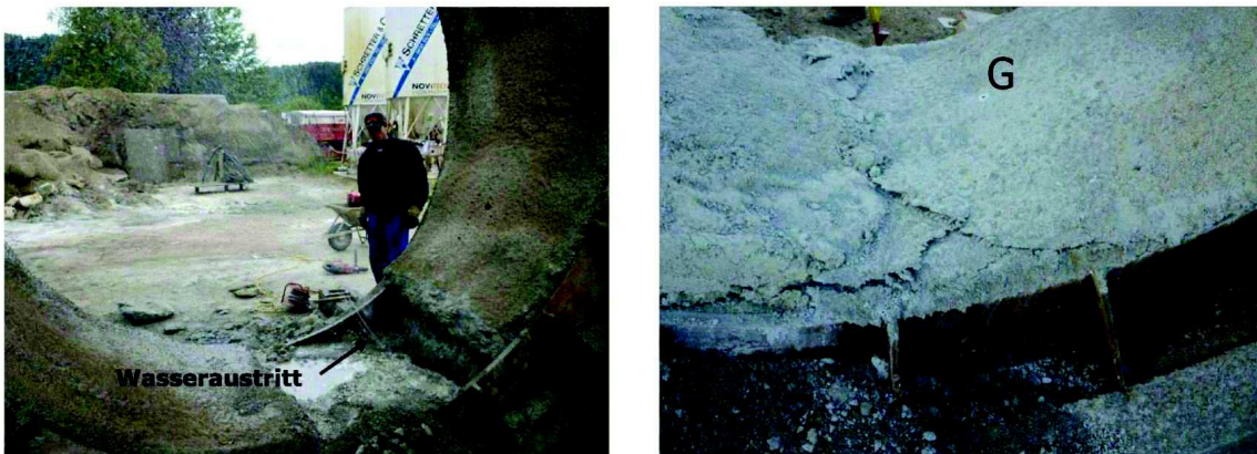
Abbildung {3} links: In Reparatur befindliche Spritzbetonschale
