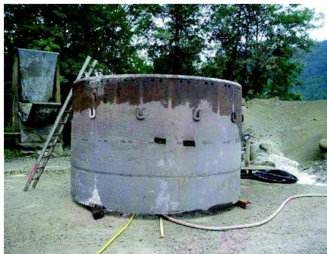
Abbildung {1}: Lage des Stahlzylinders vor Aufbringen des Spritzbetons.
