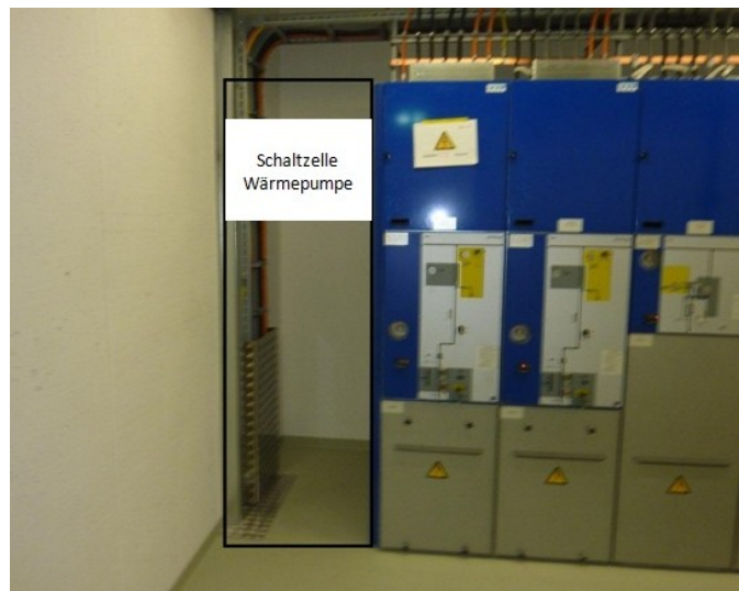
Abbildung 46: Platzmöglichkeit für eine weitere Schaltzelle
