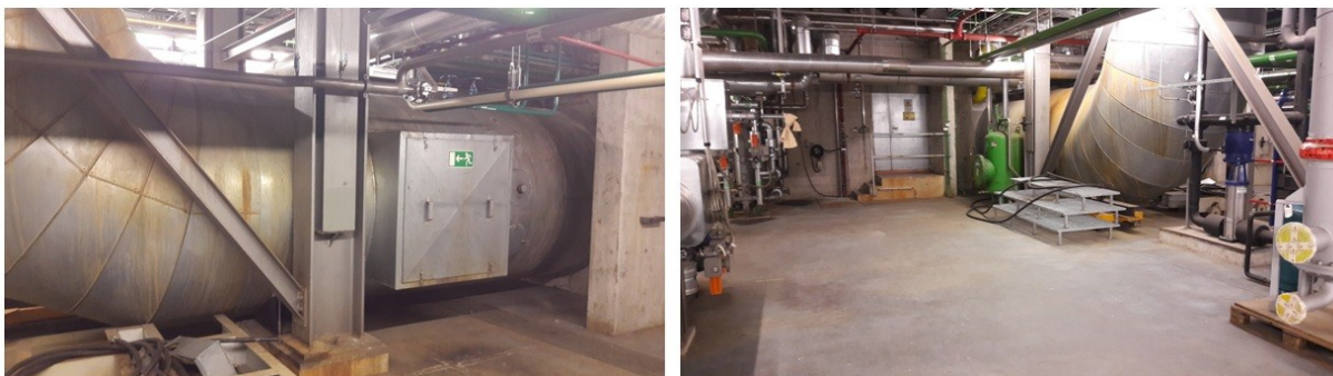
Abbildung 25: Rauchgaskanal SÖK (links) mit möglichem Wärmepumpenstandort (rechts)
