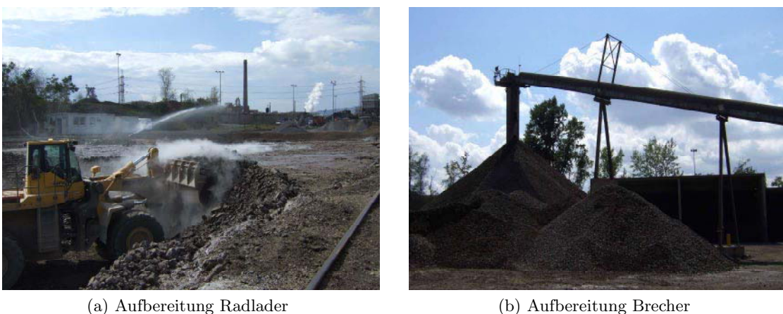
Abbildung 3.7.: voestalpine Stahl GmbH in Linz – Aufbereitung Hochofenstückschlacke
