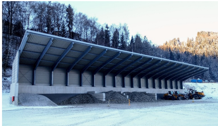
Abbildung 62: Überdachter Ladeplatz für Testläufe im Liebherr-Werk Bischofshofen
