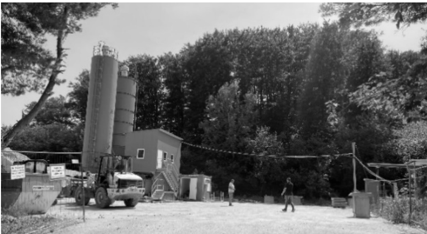
Abb. 2: Der unscheinbare, obertage befindliche Bereich der Verfüllung Preinsfeld
