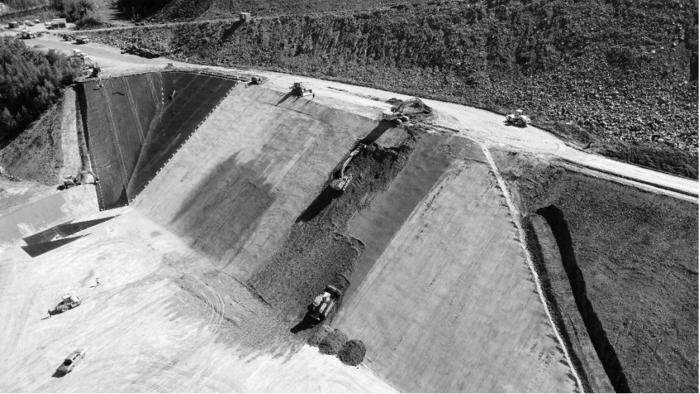
Abb. 3: 3-lagiger Einbau des vergüteten Werferner Schiefer bei ~33° Böschungsneigung
