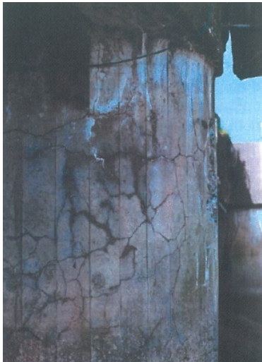
Abbildung 3: Beispiele für vernetzte Risse oder auch „Map Cracking“ a) An einem Brückenpfeiler SHRIMER 2005 b) Bauwerksaussenseite, KNAUTE 2008
