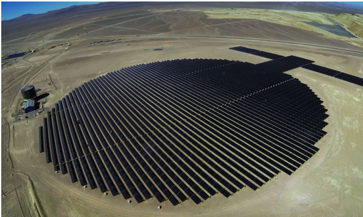
Abbildung 10: Flachplattenkollektoren Pampa Elvira [8]
