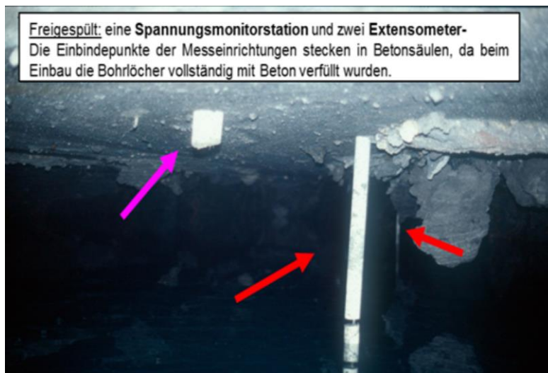
Abbildung 24: Freigelegte Betonsäulen einer Spannungsmessstation und zweier Extensometer
