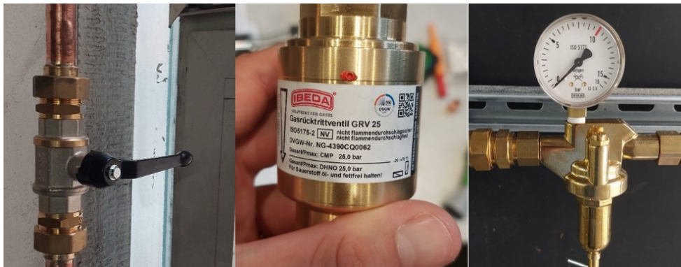
Abbildung 26: Kugelhahn (links), Gasrücktrittsventil (mitte) und Druckminderer (rechts)
