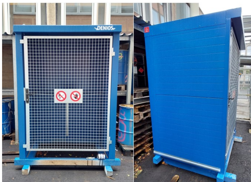
Abbildung 22: Denios Gasflaschenschrank für die Montage im Freien
