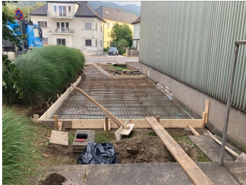
Abbildung 19: Schalungsarbeiten für die Betonfläche
