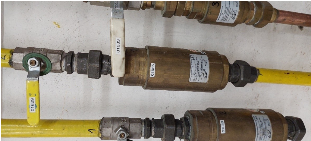
Abbildung 31: Symbolbild für Flammrückschlagsicherung der Wasserstoffregelstrecke
