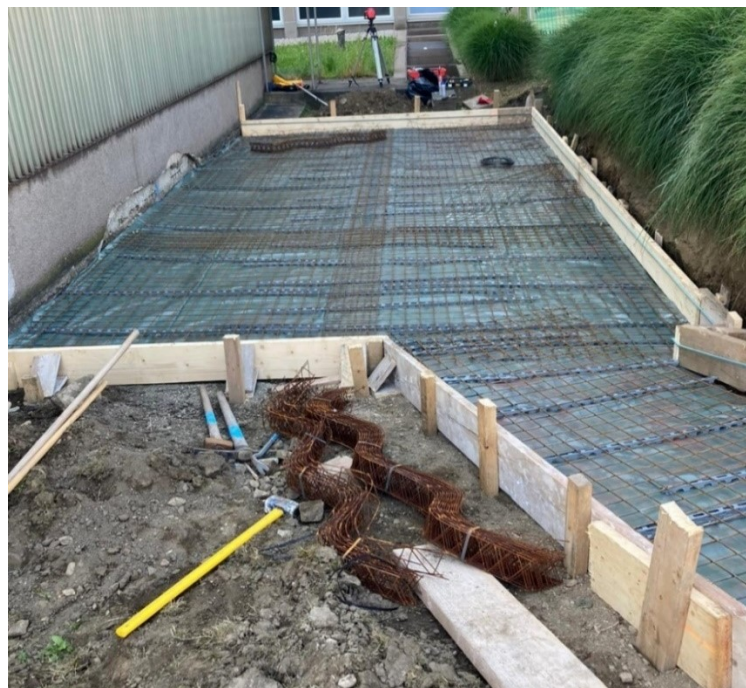
Abbildung 20: Fundamentfläche mit ausgeschalttem Weg für das Befahren mit dem Stapler
