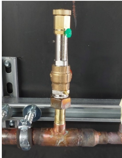
Abbildung 29: Sicherheitsventil mit 10 bar als Obergrenze
