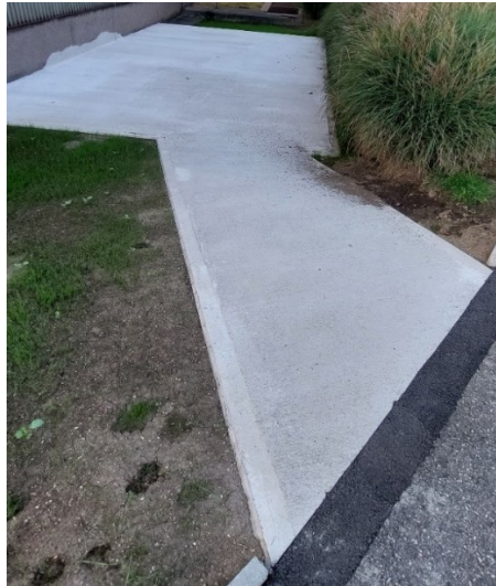
Abbildung 21: Fertig betonierte Fundamentplatte und Weg für den Stapler
