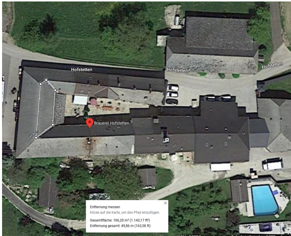
Abbildung 43: Östliche Dachfläche A6 [55]
