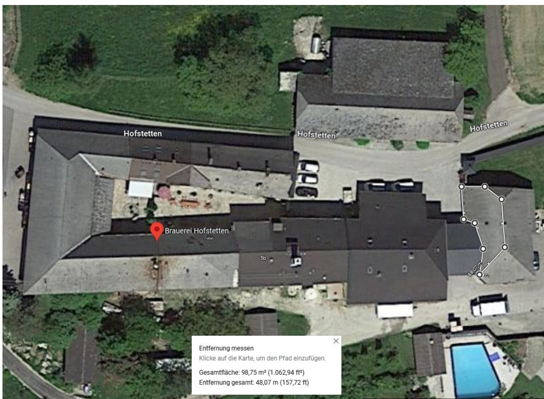
Abbildung 42: Westliche Dachfläche A5 [55]
