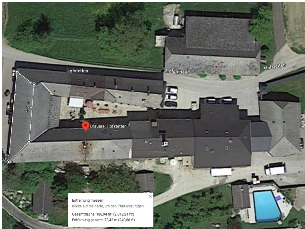
Abbildung 41: Westliche Dachfläche A4 [55]
