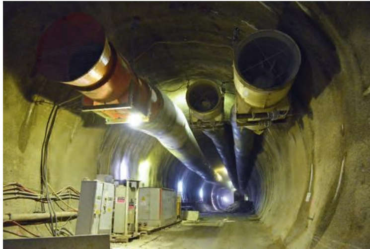
Abbildung 11 - Bewetterung mittels Lutte [13]
