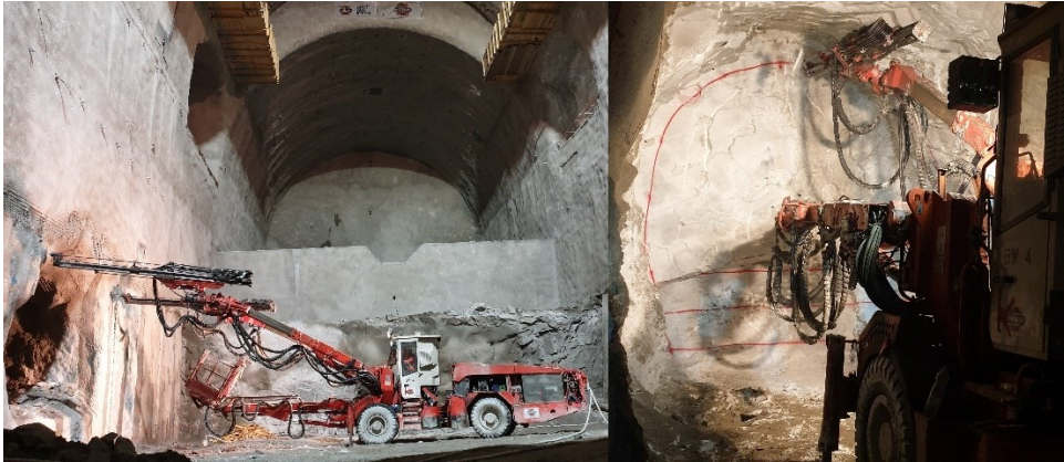
Abbildung 9 - li. Bohrwagen in Kaverne; re. Bohrwagen an Ortsbrust (Fotos: Lukas Stift)
