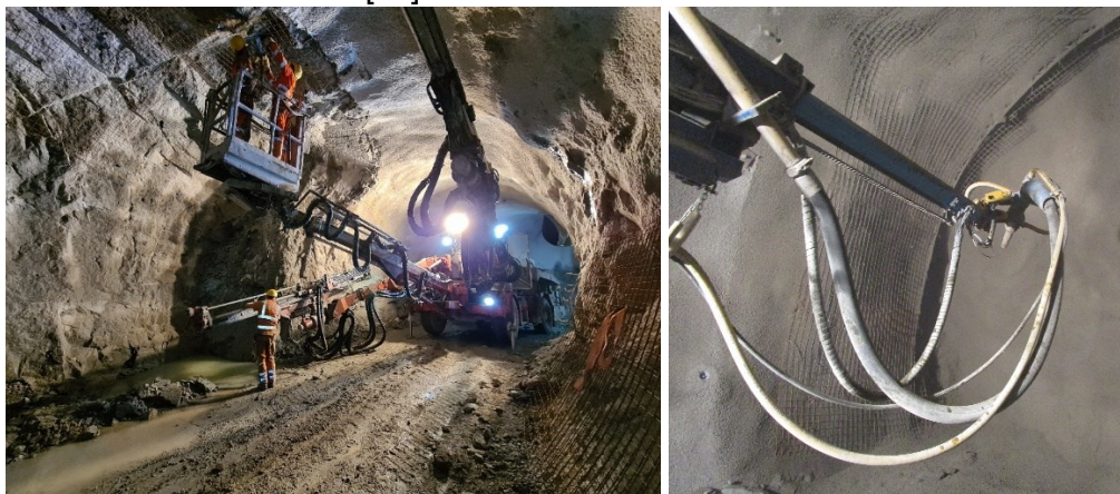
Abbildung 13 - li. Einbau Baustahlgitter; re. Einbau Spritzbeton
