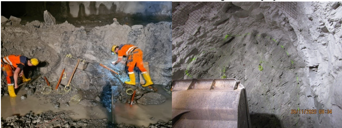
Abbildung 10 - li. Laden in Strosse; re. Beladene Ortsbrust in der Kalotte (Fotos: Lukas Stift)
