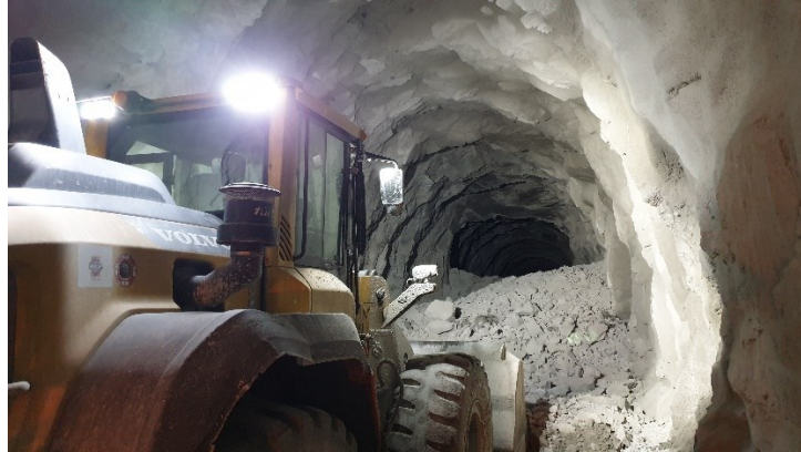
Abbildung 12 - Schüttern mit Radlader (Foto: Lukas Stift)
