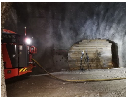
Abb. 4-32: Messpunkt TM 500 beim Abbohren der Ortsbrust
