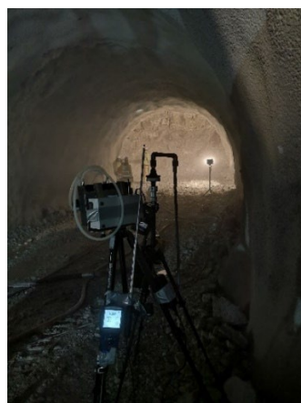
Abb. 4-34: Messpunkt TM 500 bei den Spritzbetonarbeiten
