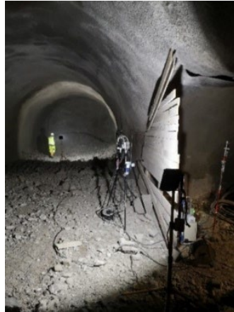
Abb. 4-33: Messpunkt TM 500 direkt nach der Sprengung
