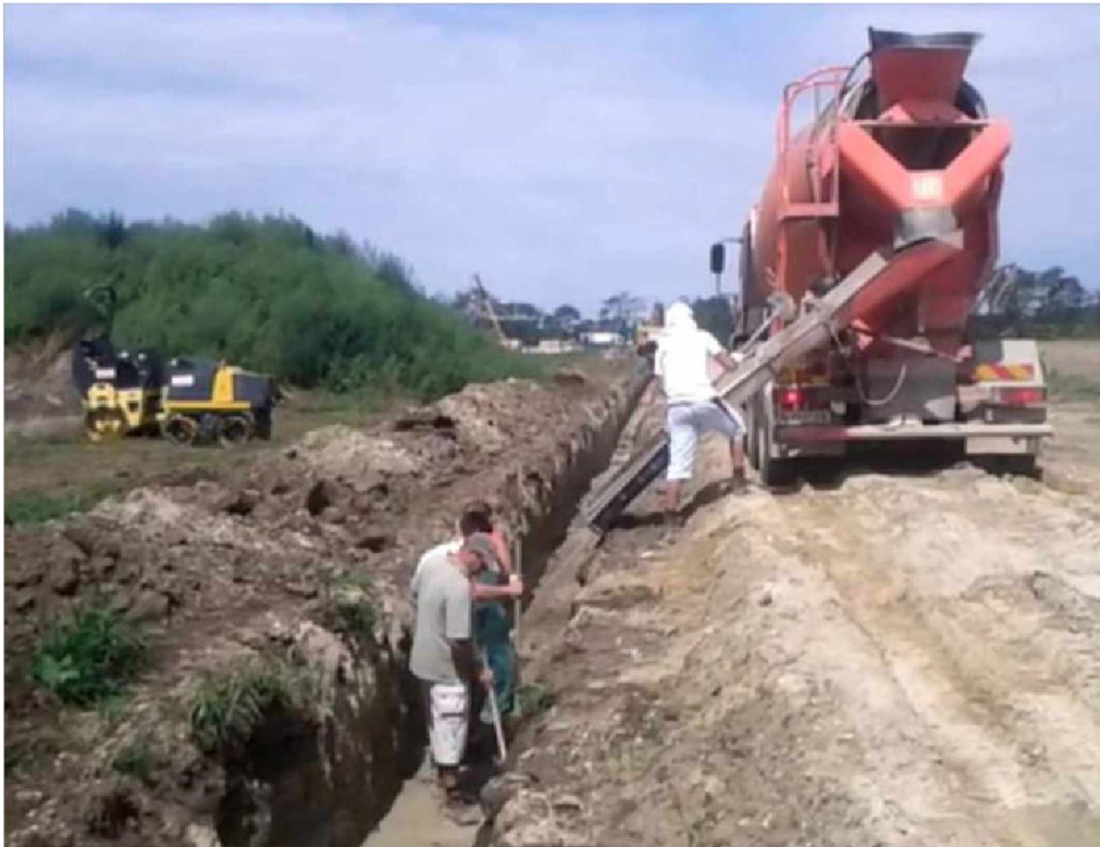
Abbildung 18: Baustelle des Pilotprojektes für technikgestützte Zeitaufnahmen
