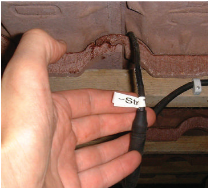
Bild 8-1 Verkabelung Stringbezeichnung
