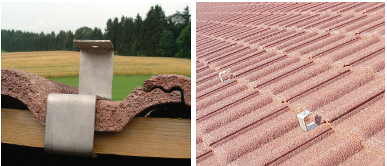
Bild 7-2 Dachhaken Montage - Detail
