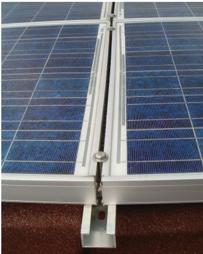
Bild 7-7 Befestigung des Moduls in der Mitte
