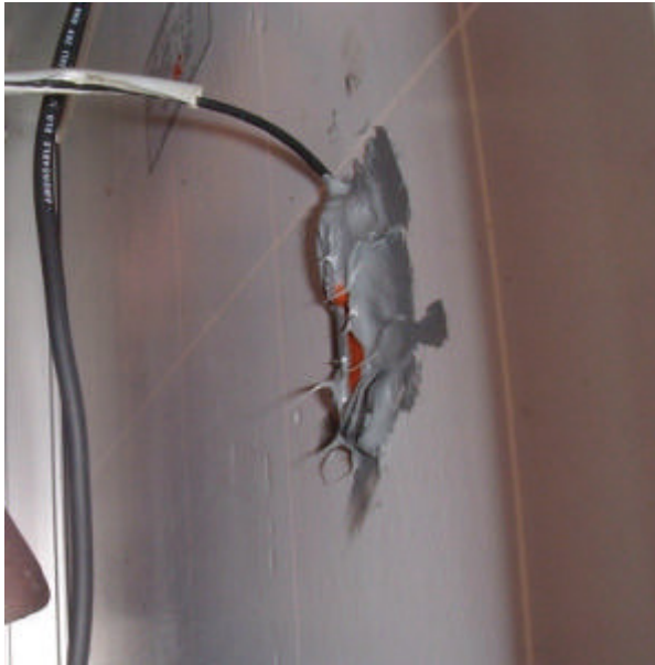
Bild 7-13 Modultemperatursensor auf der Rückseite eines Moduls
