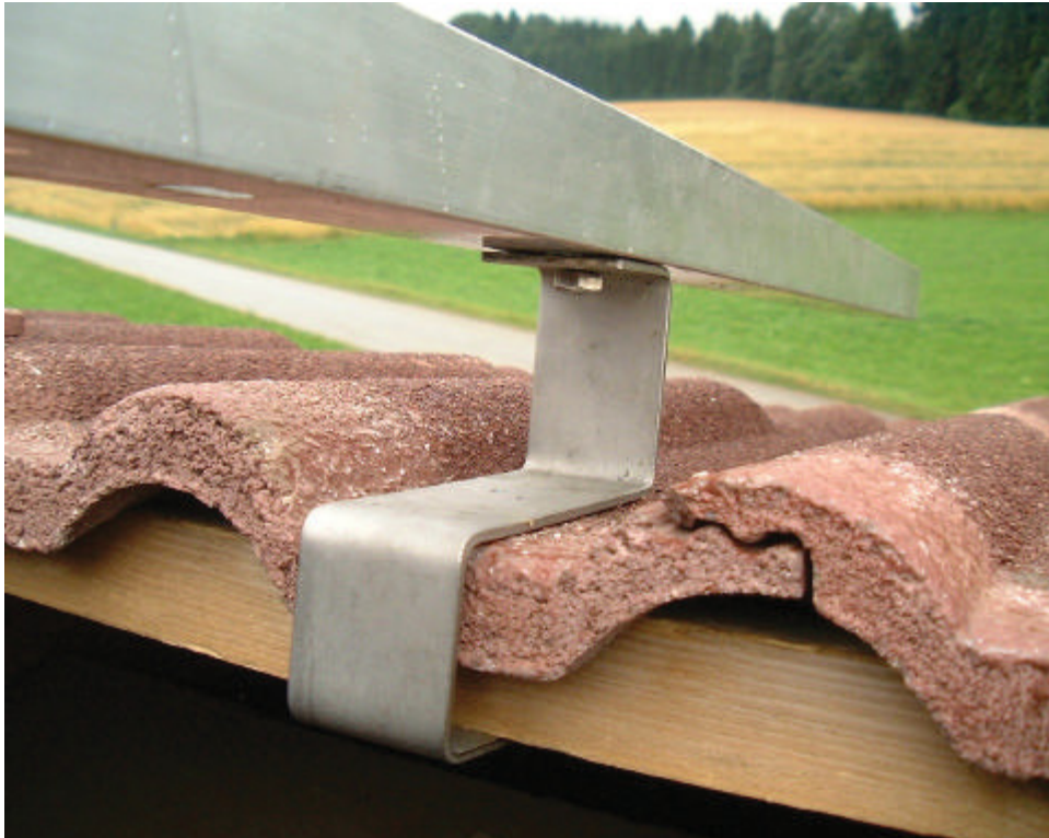
Bild 7-3 Dachhaken + Schiene Montage - Detail
