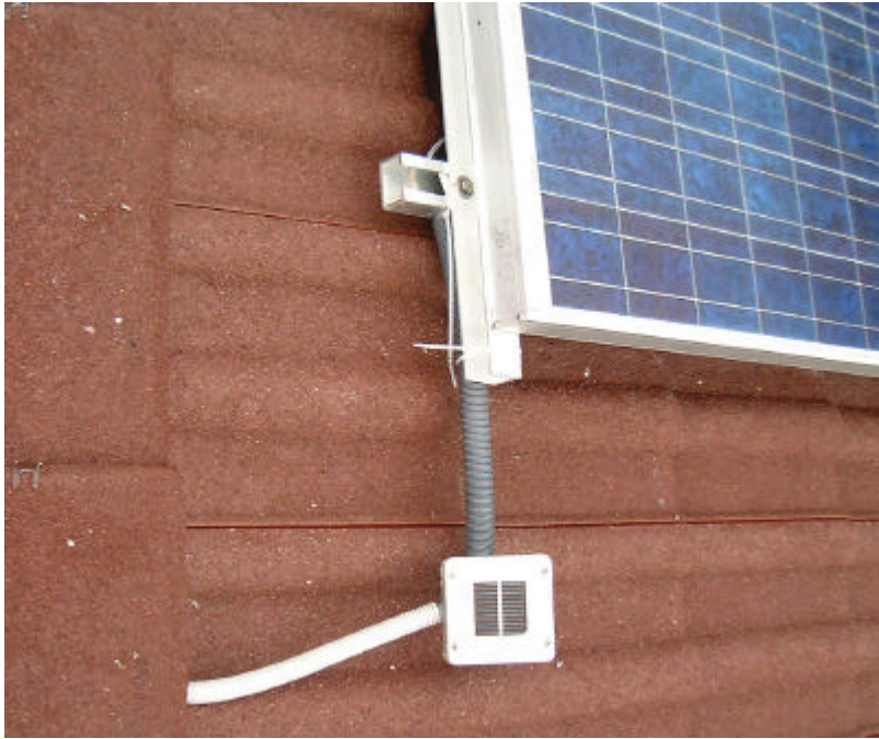
Bild 7-10 Strahlungssensor Horizontal am Giebel
