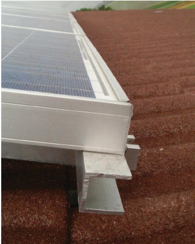
Bild 7-6 Befestigung des Moduls am Rand (oben und unten)
