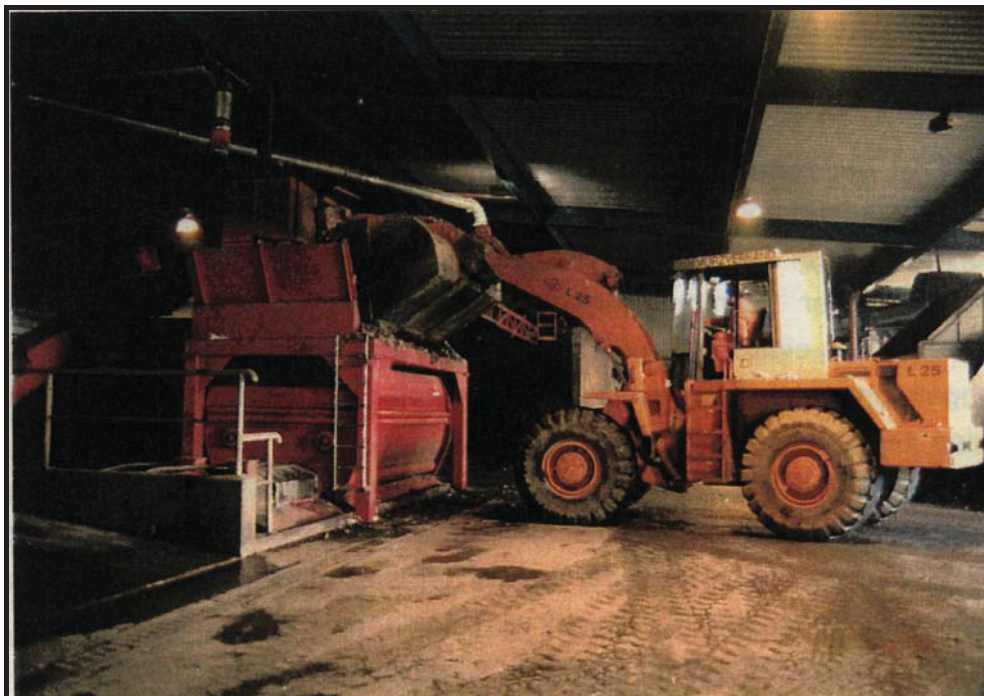
Abbildung 4.1: Restmüllaufgabe mittels Radlader
