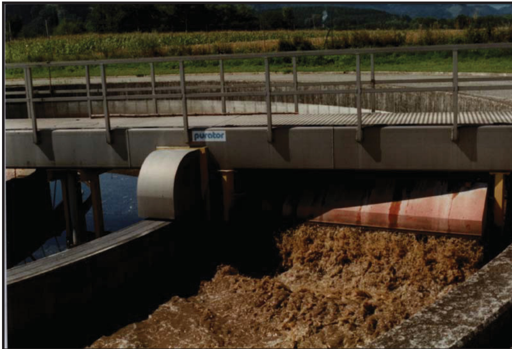
Räumerbrücke mit Mammutrotoren
