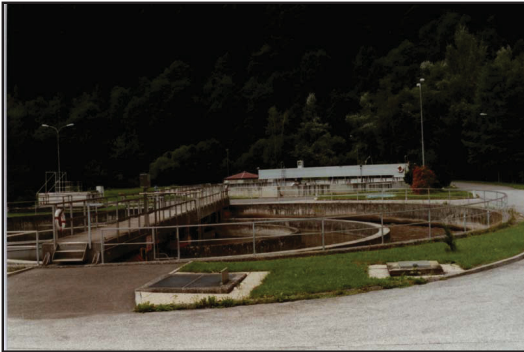
Klärblock mit Sandfang im Hintergrund in Mürz II (Wartberg)
