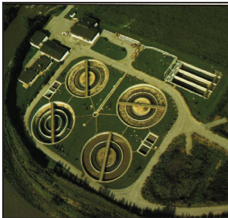
Kläranlage Mürz IV (Kapfenberg) vor dem Umbau
