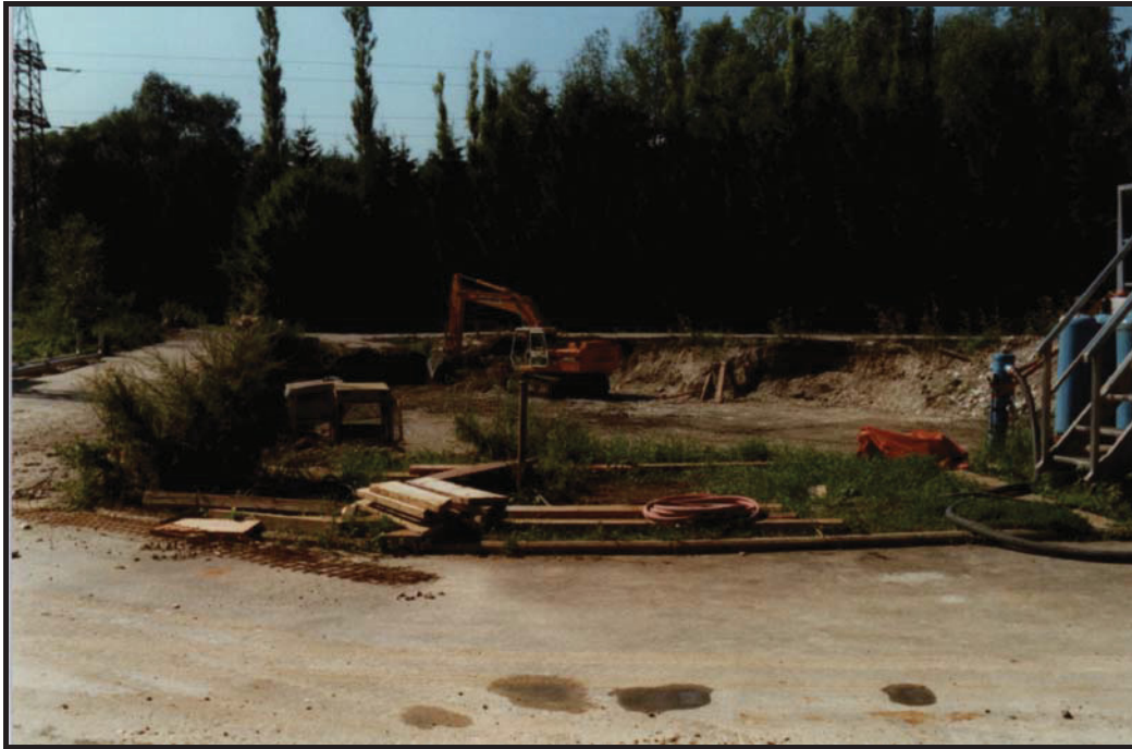
Aushub des Fundaments in Mürz IV (Kapfenberg )
