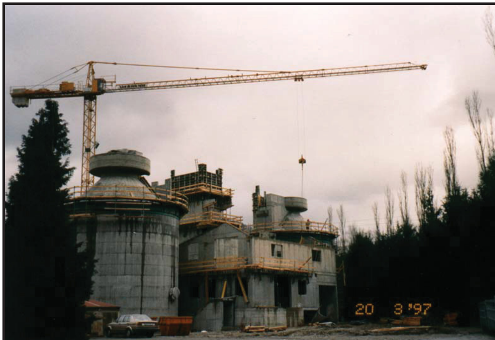
Faultürme im Bau in Mürz IV (Kapfenberg)
