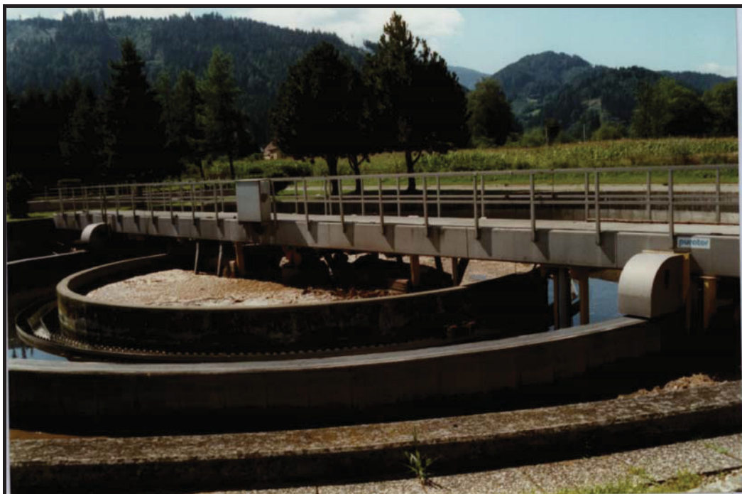
Klärblock mit Belebungsbecken, Nachklärbecken und Schlammstabilisierung (von Außen nach Innen)
