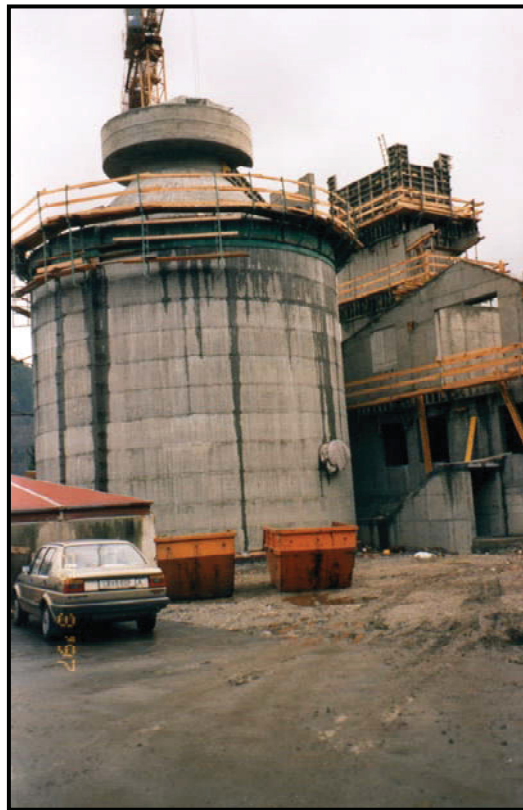
Faultürme im Bau in Mürz IV (Kapfenberg)
