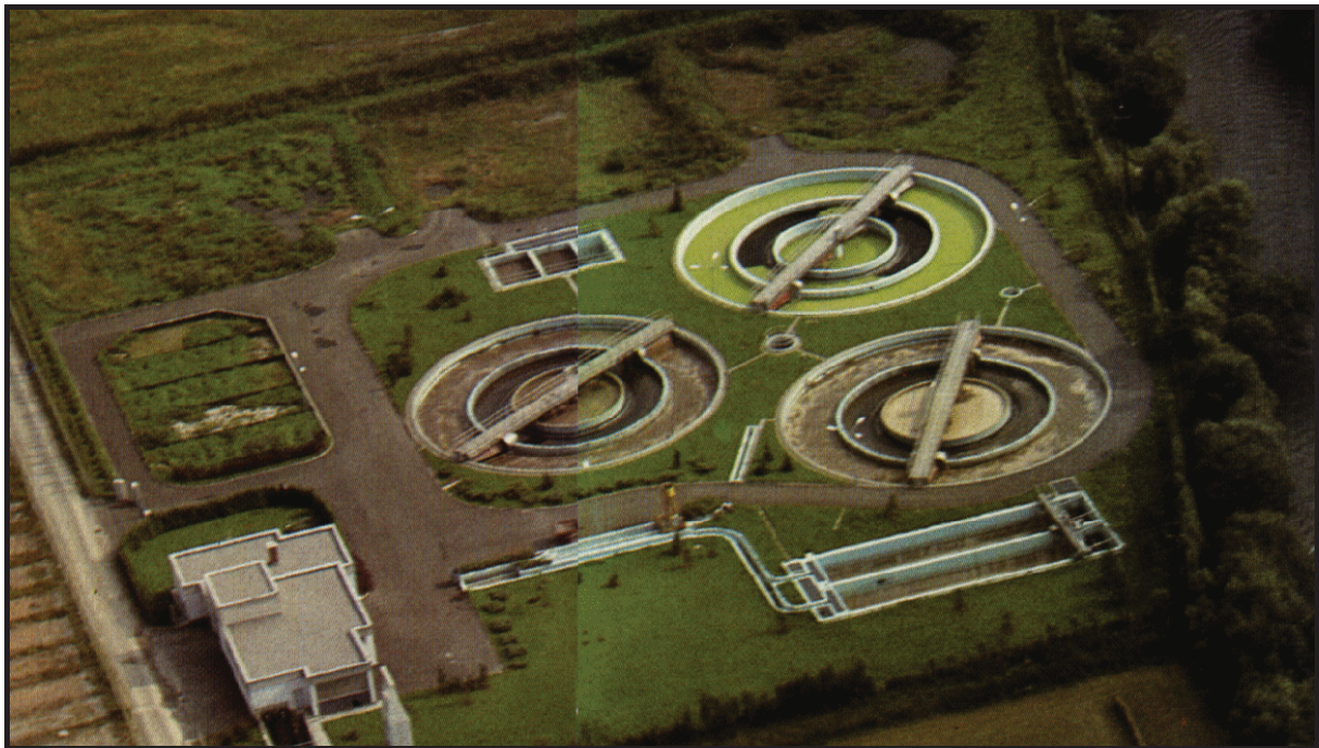
Kläranlage Mürz I (Langenwang)
