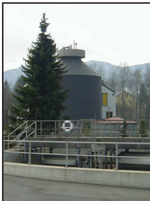
Fertiger Faulturm in Mürz IV (Kapfenberg)
