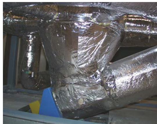
Abbildung 56: Isolation des Kegelschusses
