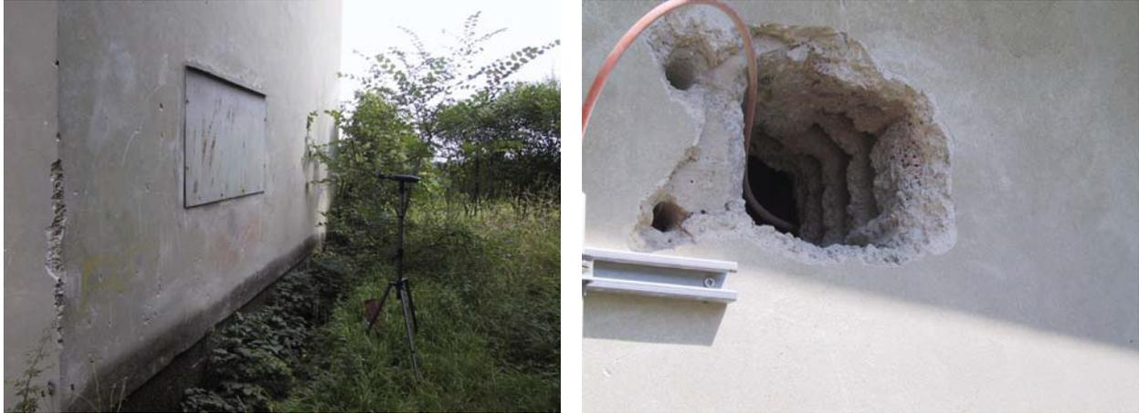
**Abbildung 7.1: lose Abdeckung und Gebäudeöffnungen**
