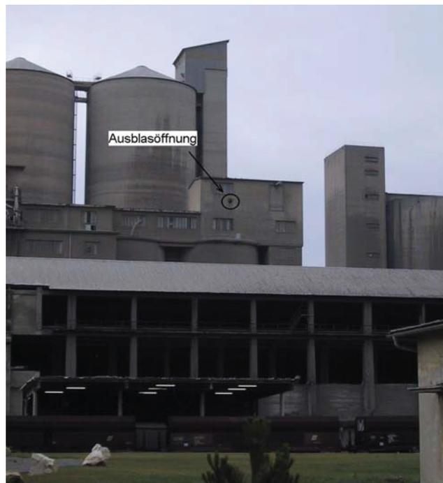
**Abbildung 1.4: Entstaubungfiltergebläse**
