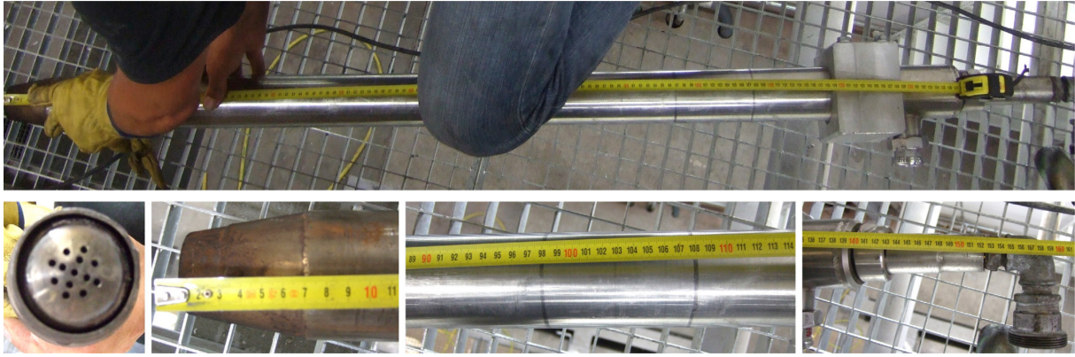
Herausgezogene, höhenverstellbare, zentrale Brennerlanze und Brennerdüse des Hauptbrenners [32]
