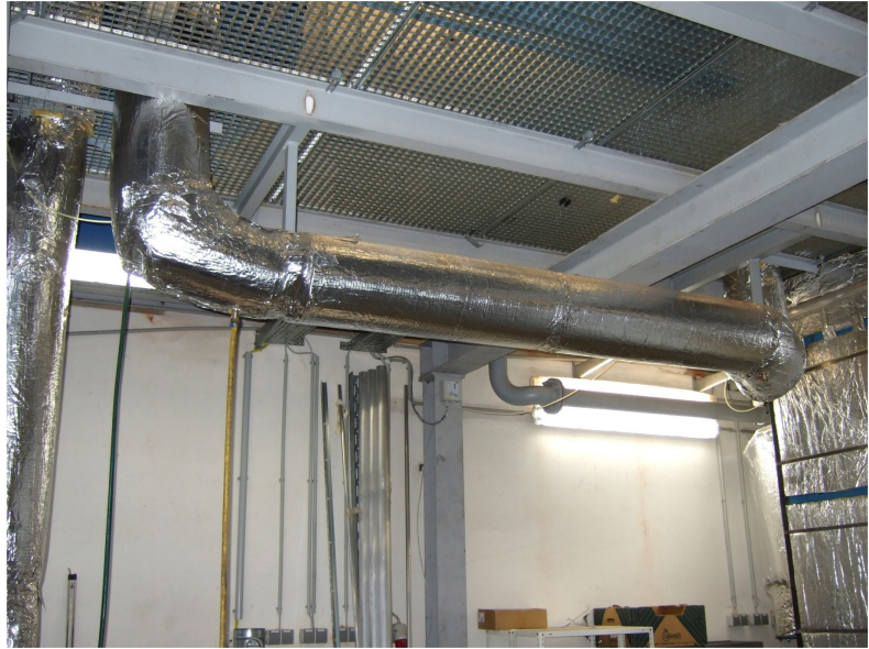
Isolierte Abgasleitung am Ausgang des Filterhauses mit Abgaserfassung zur Abgasanalyse (linkes Bild); Isolierte Abgasleitung zwischen Filterhaus und Saugzuggebläse (rechtes Bild) [32]
