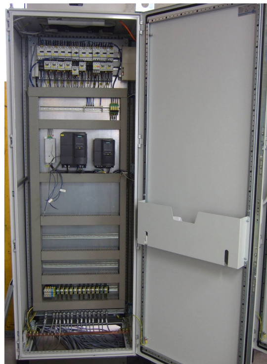
Klimatisierter Schaltschrank im OG des Technikums [32] [123]
