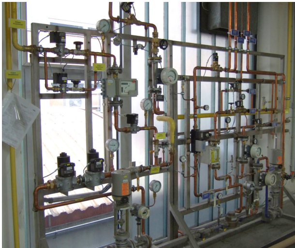
Gasregelstrecke für Erdgas, Sauerstoff und Stickstoff auf der Südseite im OG des Technikums [32]
