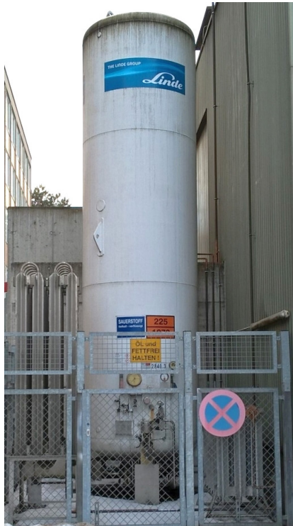
Sauerstoffversorgungsanlage im Außenbereich mit 6.000 l Tank (linkes Bild) und Stickstoffversorgungsanlage im Außenbereich mit 3.100 l Tank (rechtes Bild) [32]
