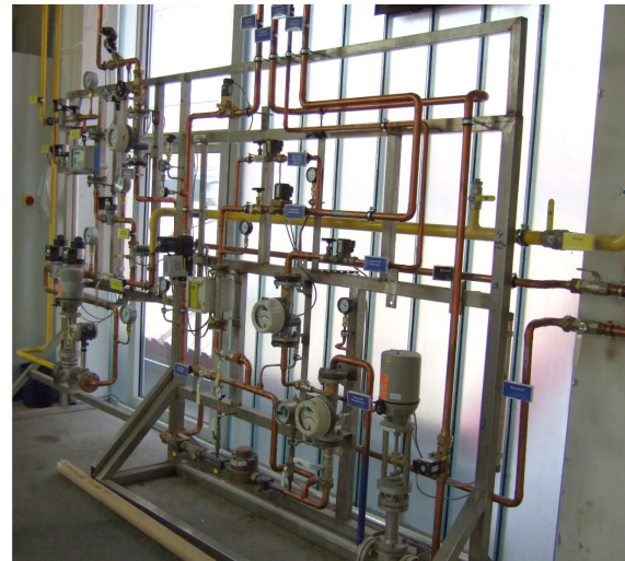
Gasregelstrecke für Erdgas, Sauerstoff und Stickstoff auf der Südseite im OG des Technikums [32]
