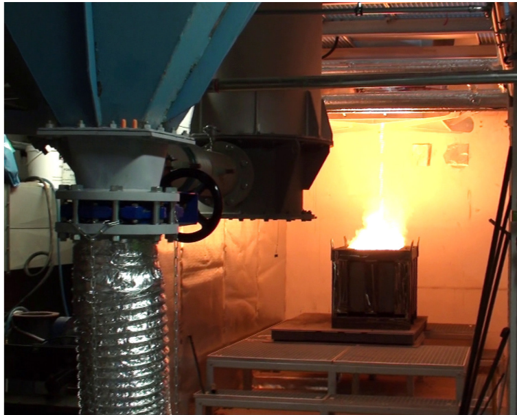
Abstichwanne am Stahlgerüst unterhalb der Brennkammer im UG des Technikums für die abfließende, flüssige, heiße Schlacke bei Abstich am 14.07.2010 [32]
