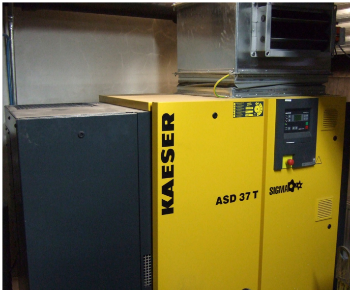
Druckluftversorgungsanlage bzw. Schraubenkompressor im UG des Technikums (linkes Bild); Druckluftregelungsstrecke im UG des Technikums (rechtes Bild) [32]
