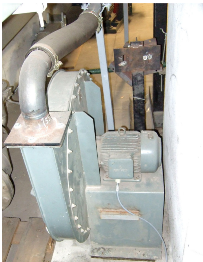
Air-Mix Gebläse (linkes Bild) und Air-Mix Regelstrecke (rechtes Bild) im UG des Technikums [32]
