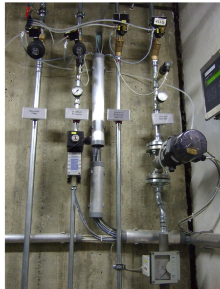
Druckluftversorgungsanlage bzw. Schraubenkompressor im UG des Technikums (linkes Bild); Druckluftregelungsstrecke im UG des Technikums (rechtes Bild) [32]
