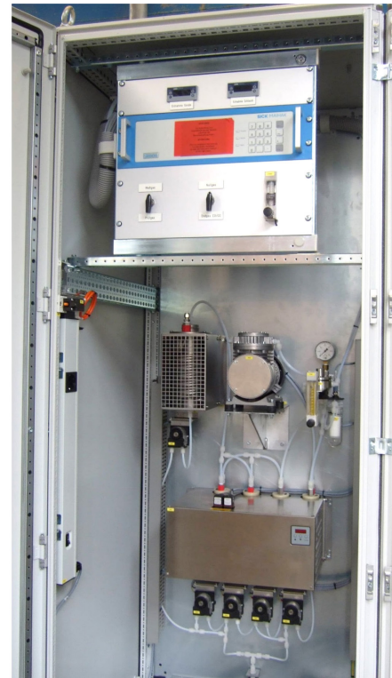
Schaltschrank im UG des Technikums (linkes Bild); CO und H 2 Gasanalyseschrank im EG des Technikums zur Analyse des Abgases (rechtes Bild) [32] [123]
