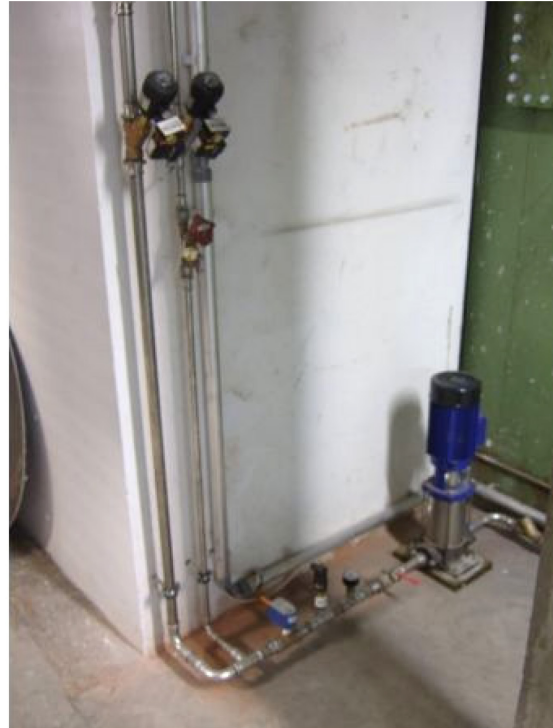
Betriebswasserpumpe und Sensorik der Betriebswasserhauptleitung im UG des Technikums vor dem Wasserspeicher [32] [123]
