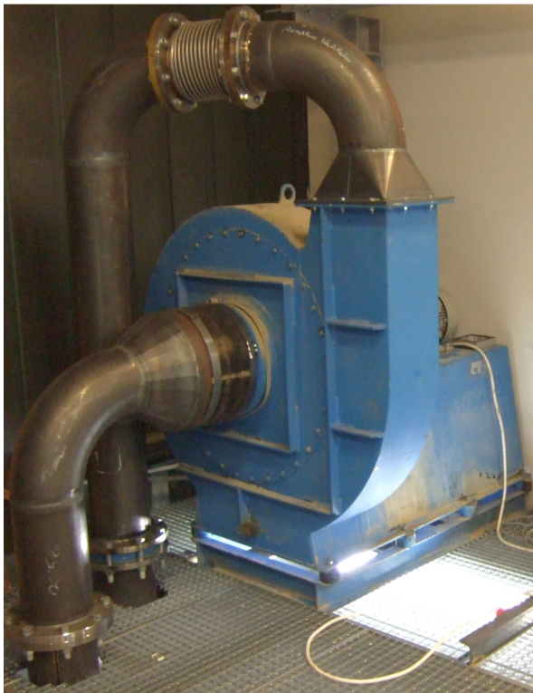
Saugzuggebläse ohne (linkes Bild) und mit (rechtes Bild) Isolierung der zu- und abführenden Abgasleitung [32]
