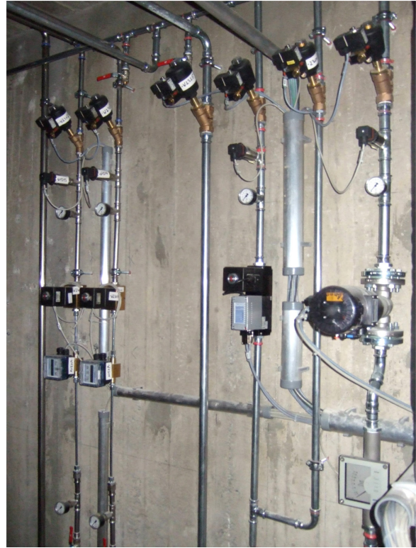
Wasser- und Druckluftregelstrecke im UG des Technikums [32] [123]
