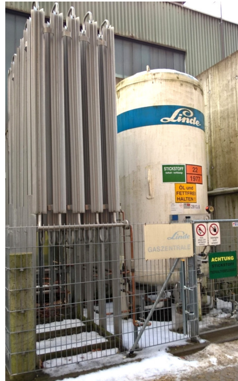
Sauerstoffversorgungsanlage im Außenbereich mit 6.000 l Tank (linkes Bild) und Stickstoffversorgungsanlage im Außenbereich mit 3.100 l Tank (rechtes Bild) [32]
