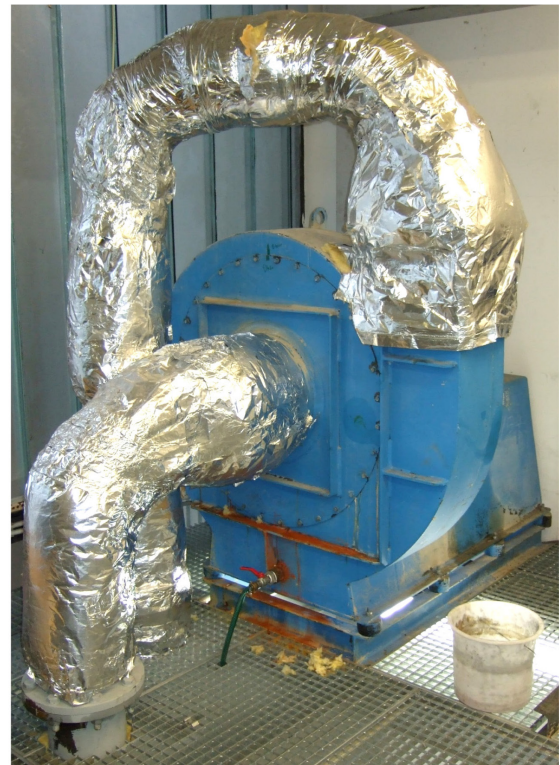
Saugzuggebläse ohne (linkes Bild) und mit (rechtes Bild) Isolierung der zu- und abführenden Abgasleitung [32]
