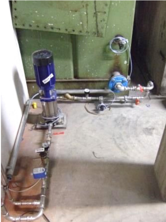
Betriebswasserpumpe und Sensorik der Betriebswasserhauptleitung im UG des Technikums vor dem Wasserspeicher [32] [123]
