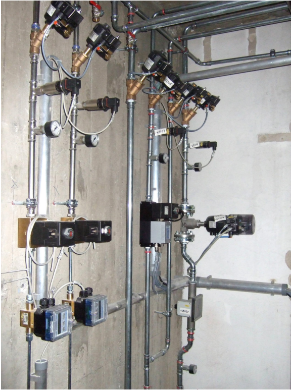
Wasser- und Druckluftregelstrecke im UG des Technikums [32] [123]
