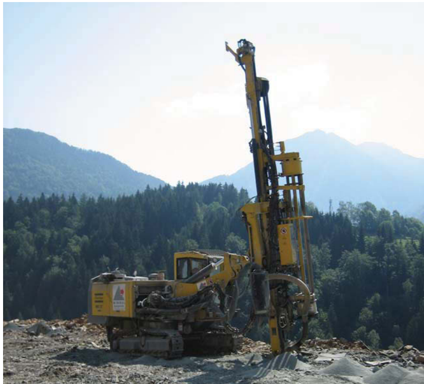
Abb. 5: Bohrgerät Atlas Copco ROC 7F
