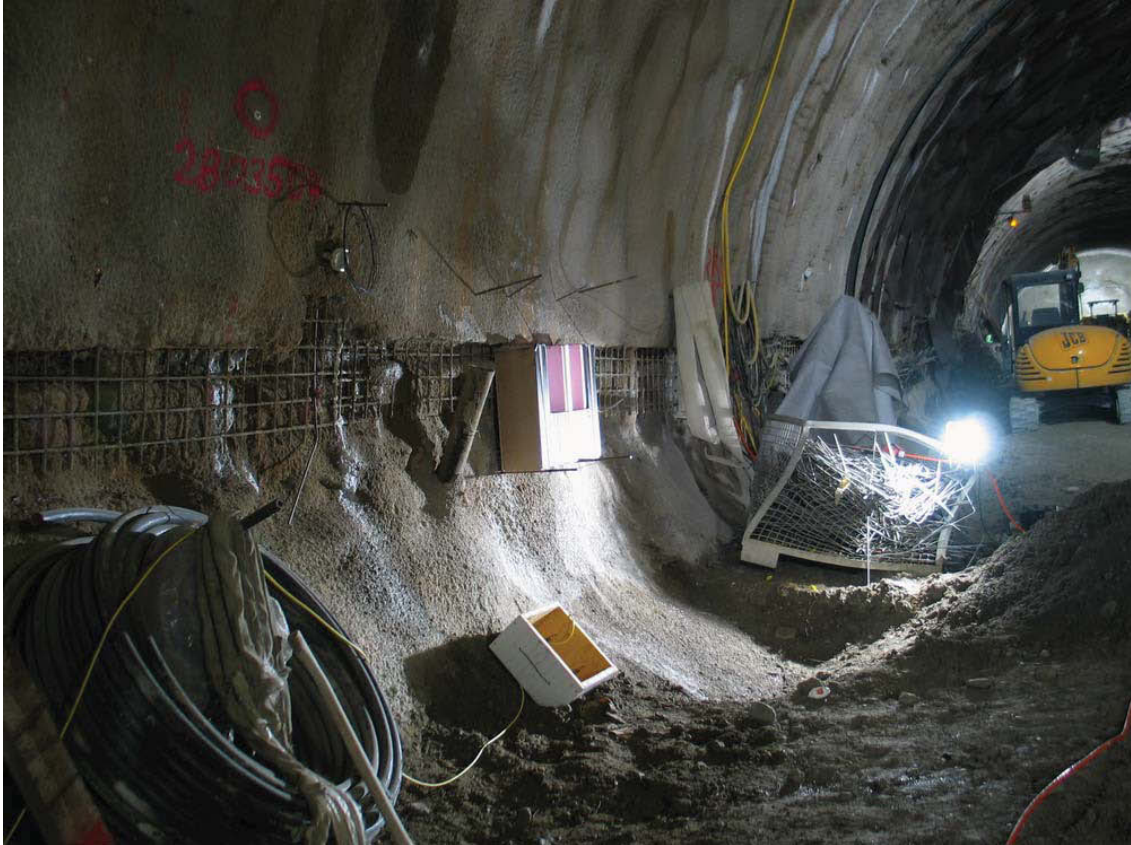
Abb. 29.: Schalung vor dem Einspritzen
