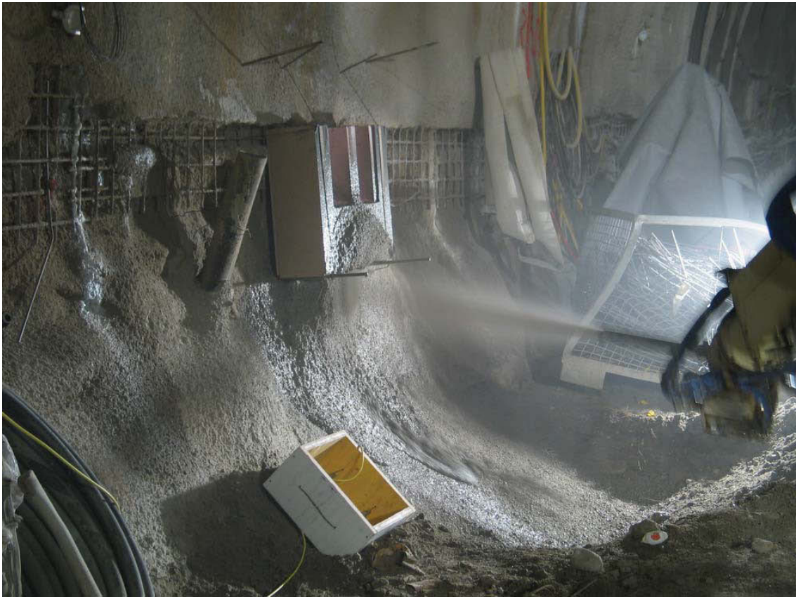
Abb. 30.: Spritzen des Sockel (Widerlager für den Druckzylinder)
