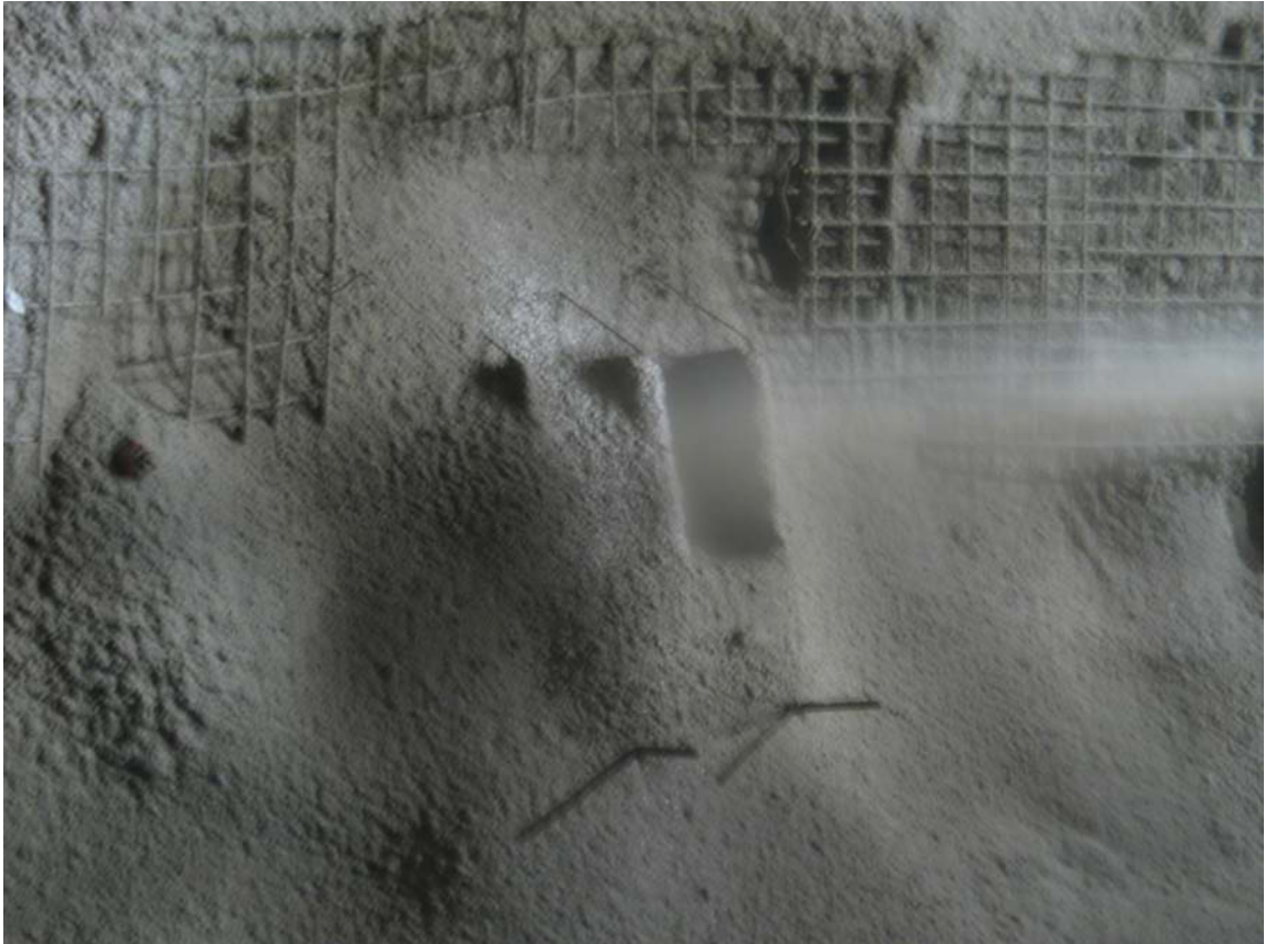
Abb. 31.: Einspritzen der Schalung
