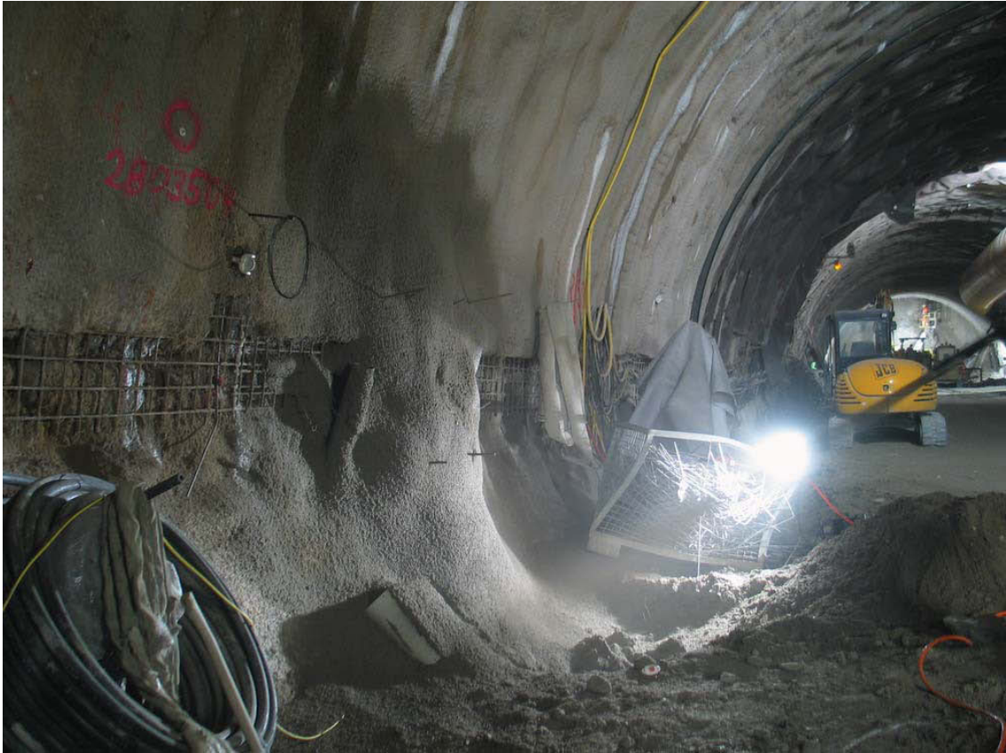
Abb. 32.: Nach Einspritzen der Schalung
