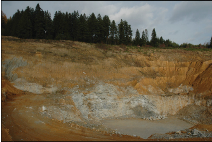
Abb. 26: Ausbildung der Überlagerung am Beispiel des Tagbaues von Šafárka. Bei dem hellgrauen Gestein handelt es sich um die Wertminerale in Form von Gips und Anhydrit, das dunkelgraue Gestein ist Dolomit.
