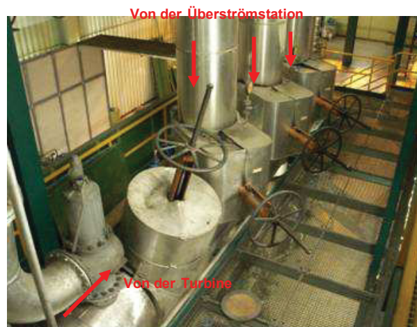
Abbildung 24: Niederdruckverteiler
