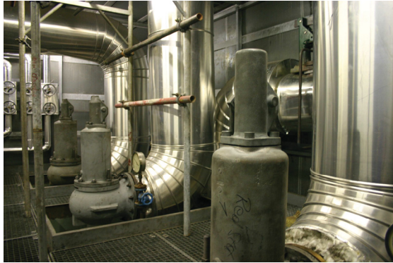
Abbildung 15: Reduzierstation
