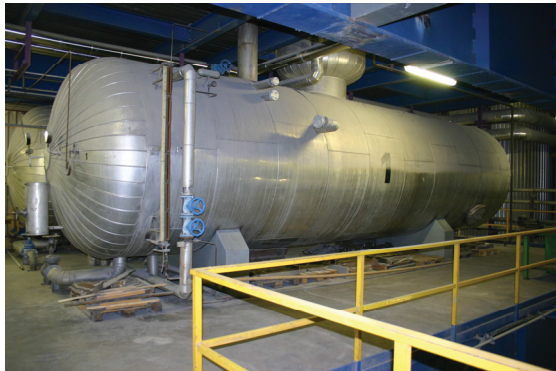
Abbildung 4: Speisewasserbehälter
