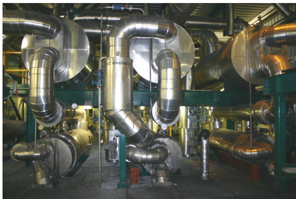
Abbildung 25: Kondensator- und Kondensatkühlergruppe
