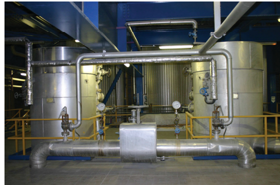
Abbildung 5: Entgaser
