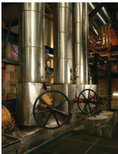
Abbildung 23: Niederdruckverteiler
