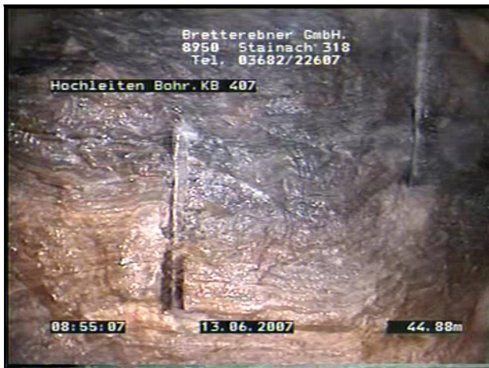
Abb. 42: „Bohrlochpfeifen“ zeigen, dass der Schacht von oben nach unten aufgefahren wurde
