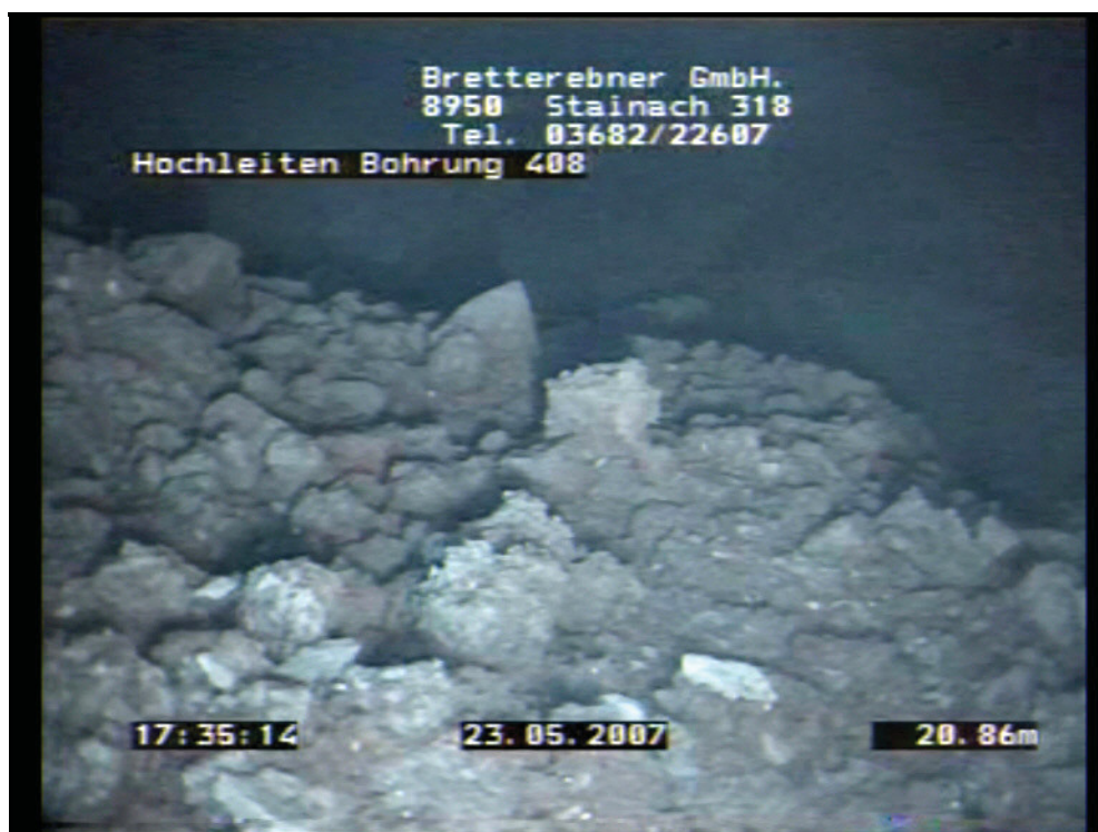
Abb. 46: Schüttmaterial, möglicherweise von der Schachtverfüllung stammend
