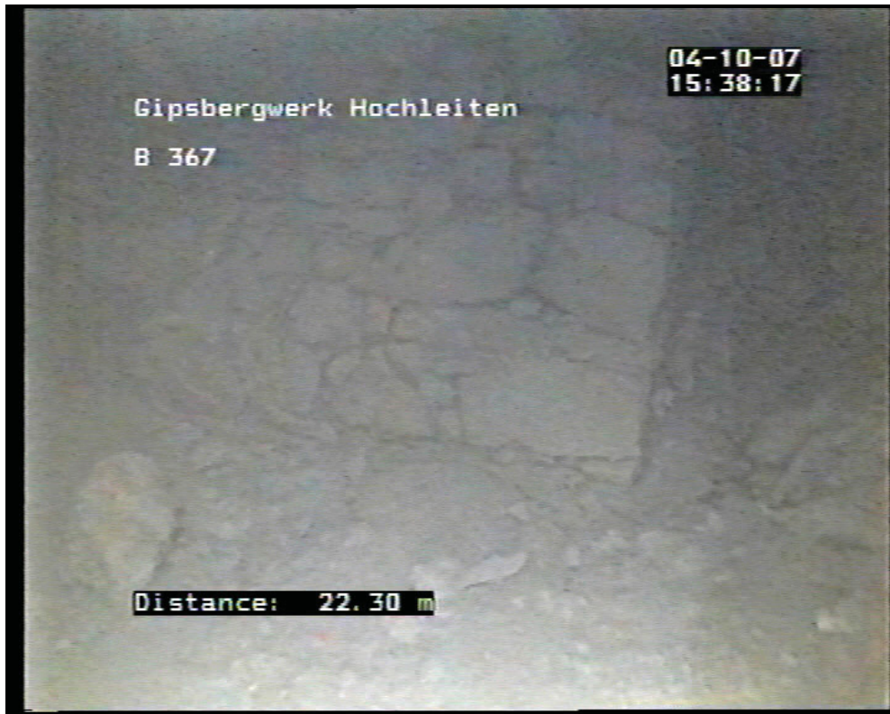
Abb. 33: BL 367; Mauerwerk untertage; kein Abbauhohlraum
