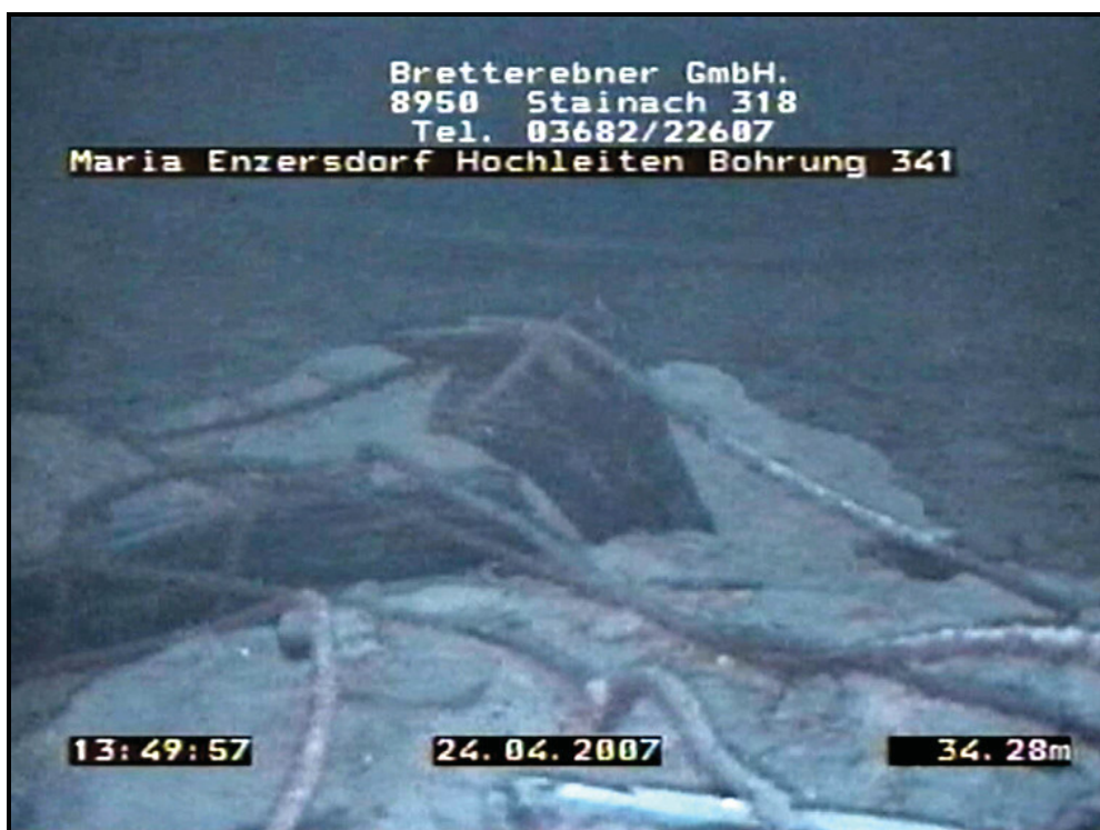
Abb. 27: BL 341: Verfallene Holzsteher und Stahlseile
