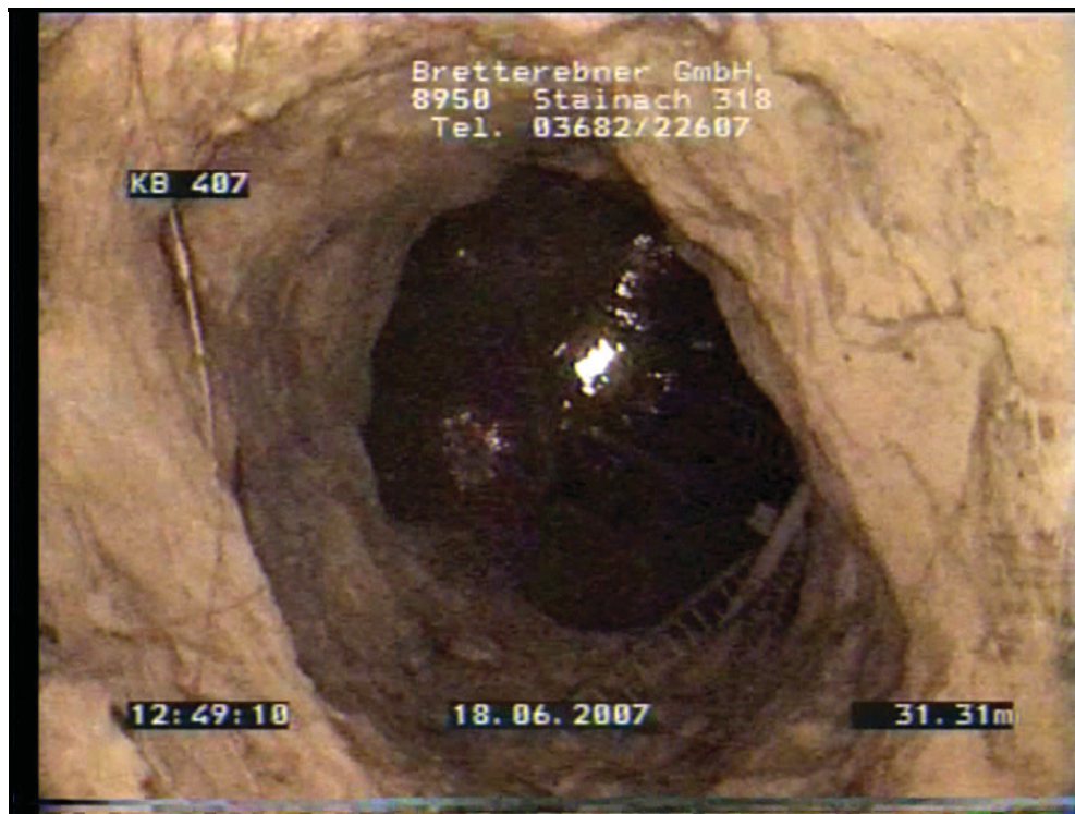
Abb. 36: Ausgepumpter Schacht über BL 407
