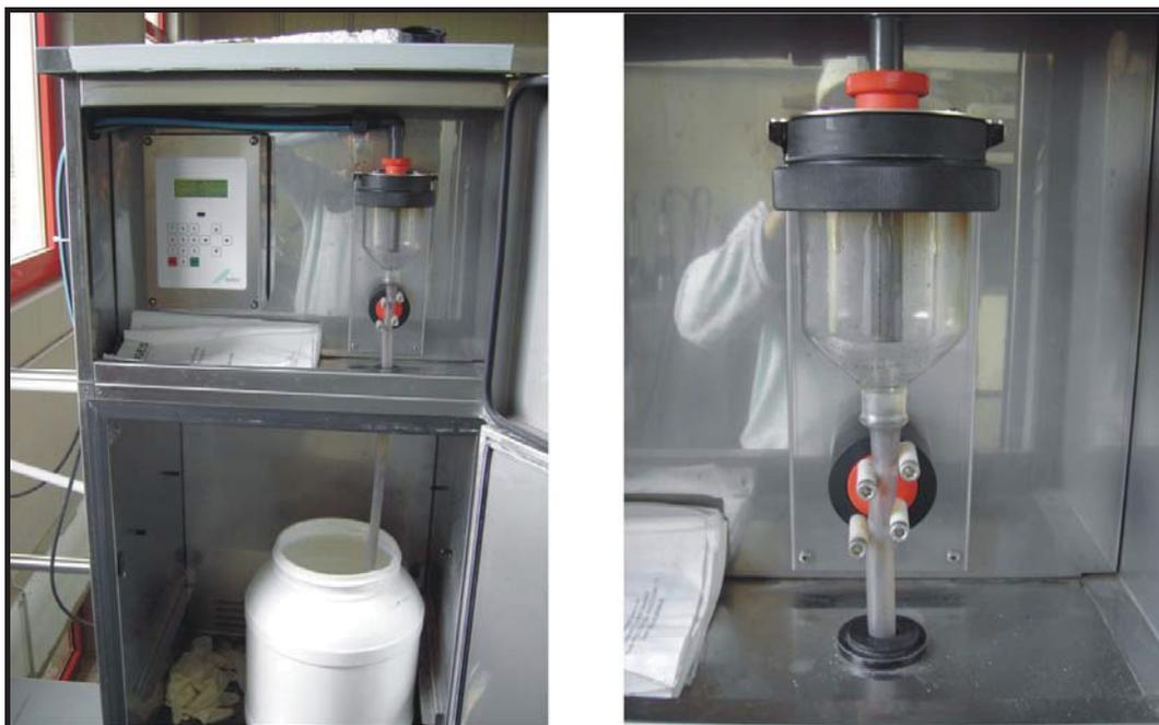
Abb. 15: Probenehmer für die Tagesmischproben am Ablauf
