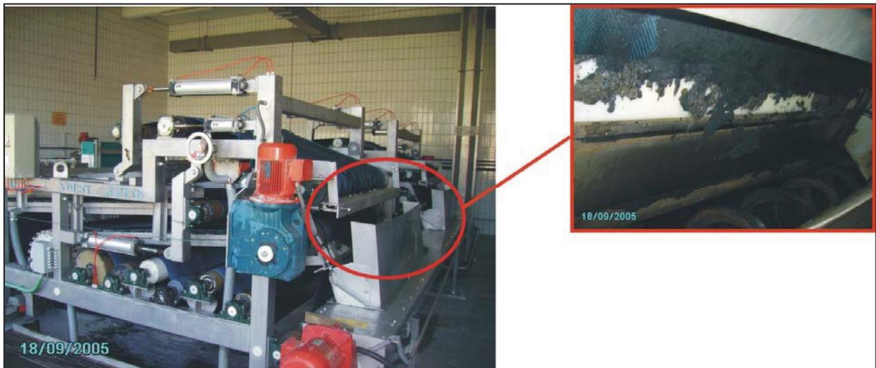
Abb. 10: Bandpresse mit Probeentnahmestelle in der Kläranlage Leoben
