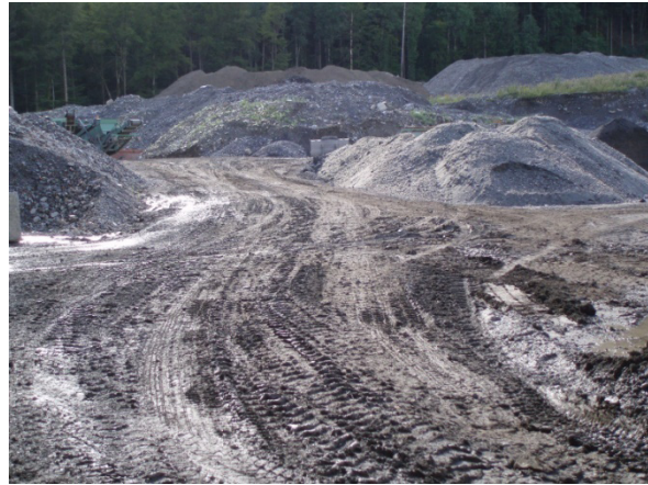
Bodenaushub in versch. Qualitäten
