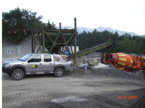
Zement wird zugegeben
