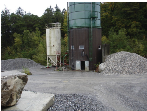
Kläranlage mit neuem Wassertank
