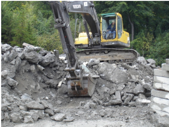
Sortieren des Betonabbruchs
