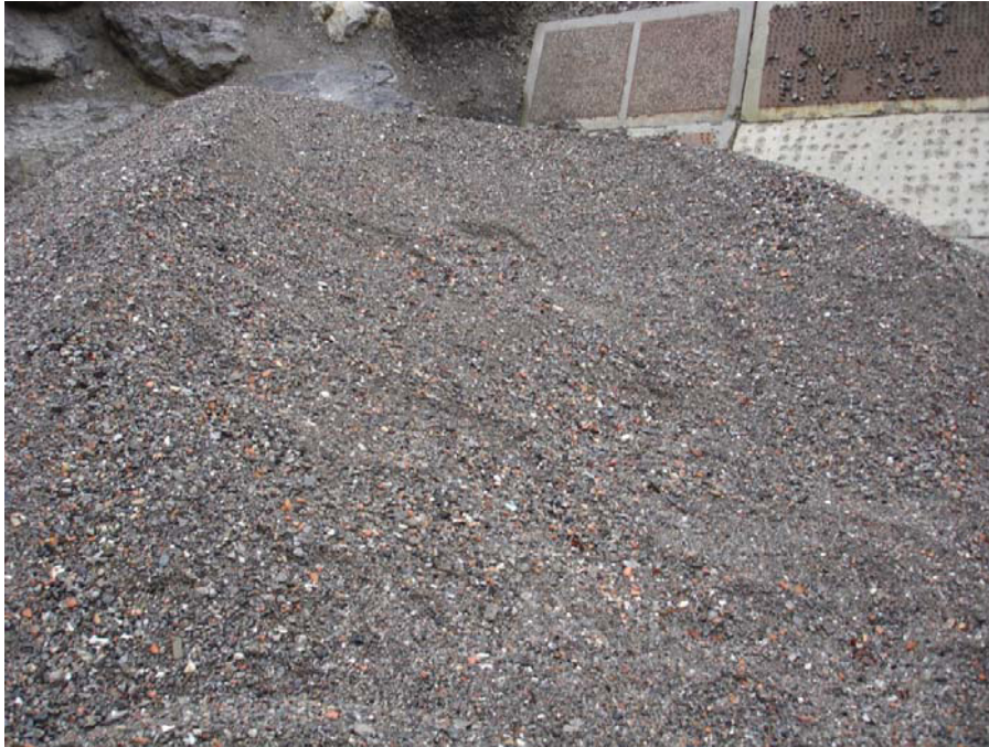
Abbildung 55: Mischabbruchkies für die Betonplatte
