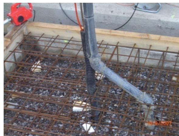
Schalung mit Bewehrung
