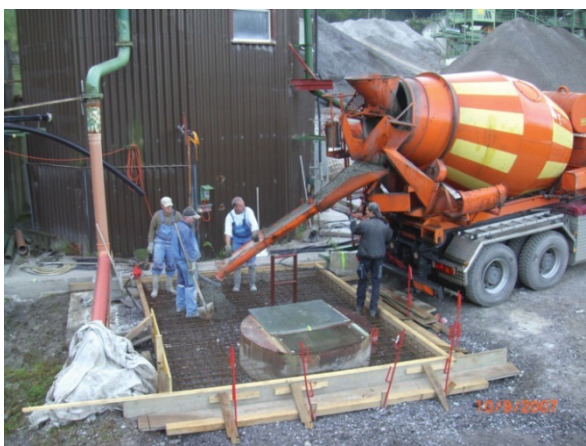
Beginn der Betonierarbeiten
