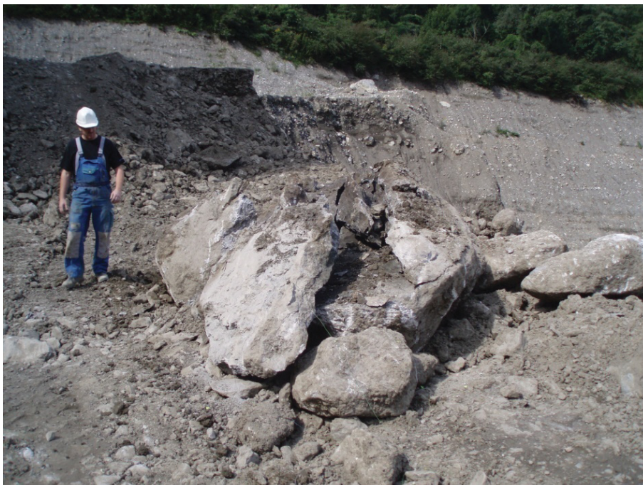
Abbildung 5: Sprengerfolg der Freisteinsprengungen
