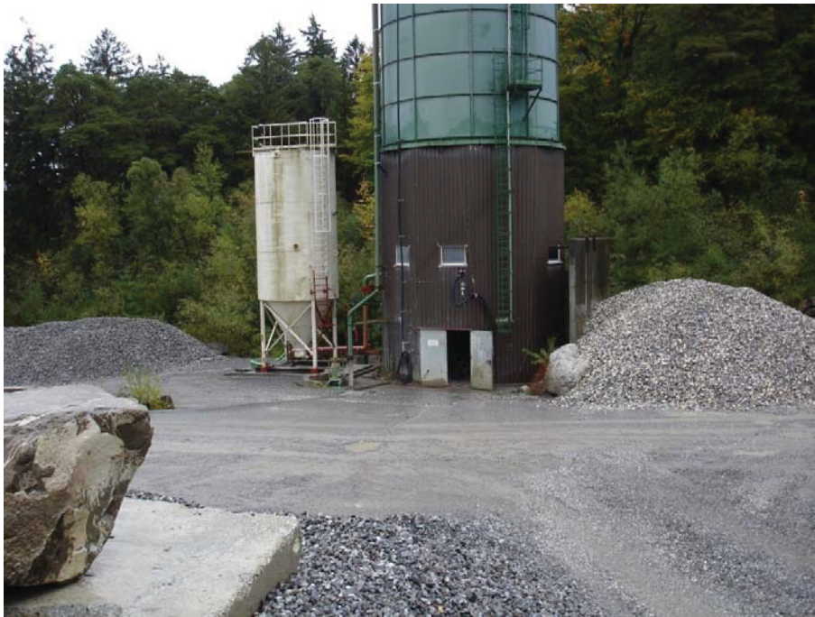
Abbildung 18: Kläranlage mit neuem Zwischentank
