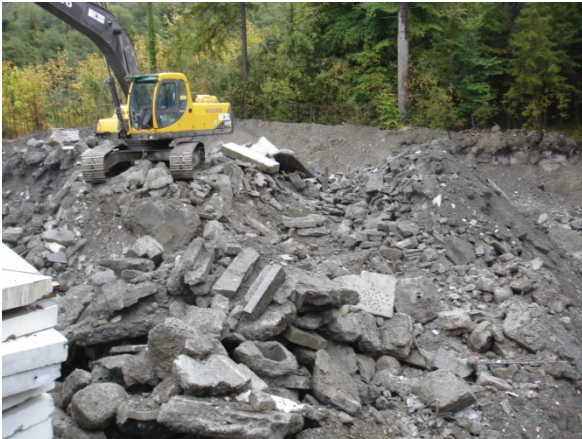
Zwischenlager für Betonabbruch
