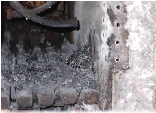
Abbildung 9.16: Situation auf den Roststäben bei der Letztversion der Primärluftführung - keine Versottungen, keine Verkrustungen auf den Roststäben
