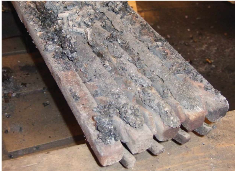
Abbildung 8.4: Verkrustungen auf den mittleren unbeweglichen Roststäben
