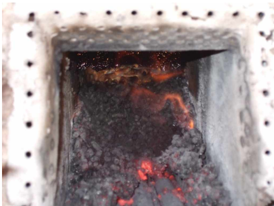
Abbildung 8.2: Situation direkt nach dem Abfahren: Primärluftgeschwindigkeit 1,9 m/s
