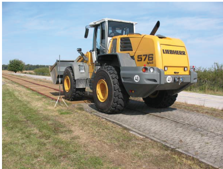
Abb. 3.5: Radlader beim Befahren der Schlechtwegstrecke
