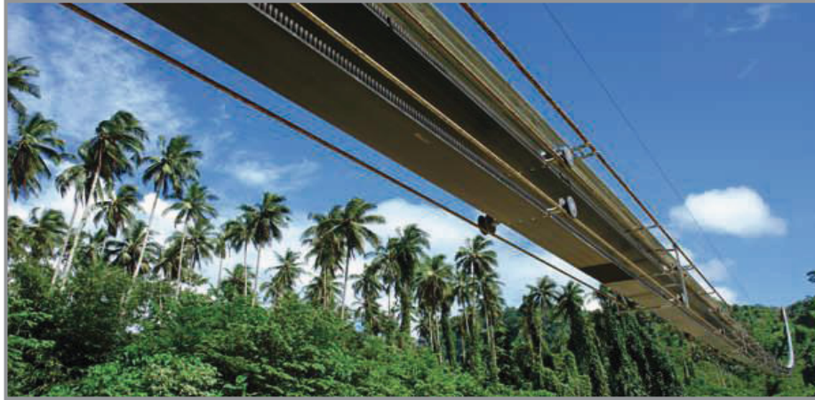
Abb. 3.3: RopeCon- Anlage mit sehr langer Spannweite (8)
