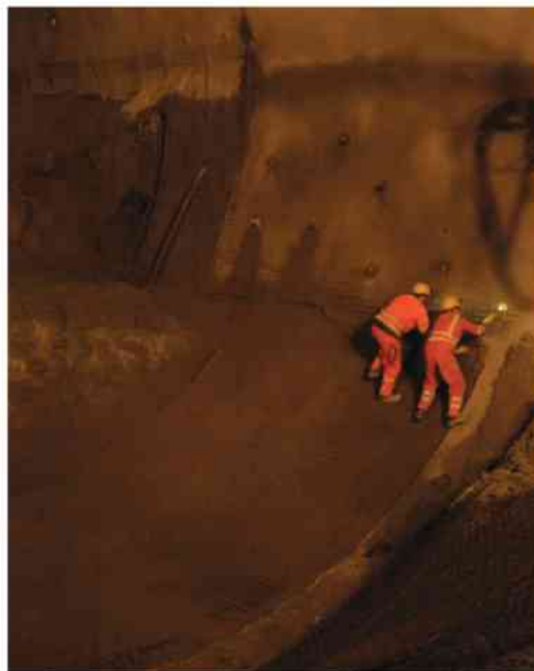
Abb. 6-49: Stein West: Gittern der Sohle
