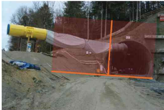
Abb. 6-4: Stein West: Verlauf der Lichtstärke im Portalbereich: Startpunkt
