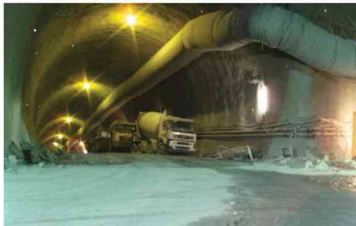
Abb. 5-72: BBT: Start der Zufahrtsrampe
