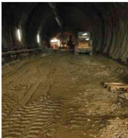
Abb. 6-98: Stein West: Fahrbahn von MP1 aus
