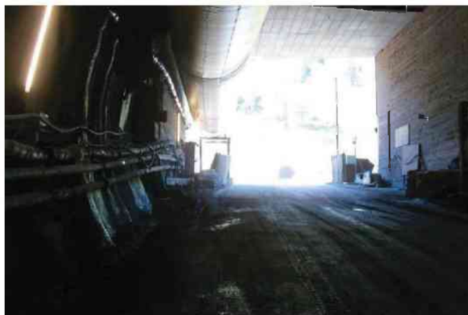
Abb. 5-2: BBT: Messung der Beleuchtung im Portalbereich: Blick hinaus
