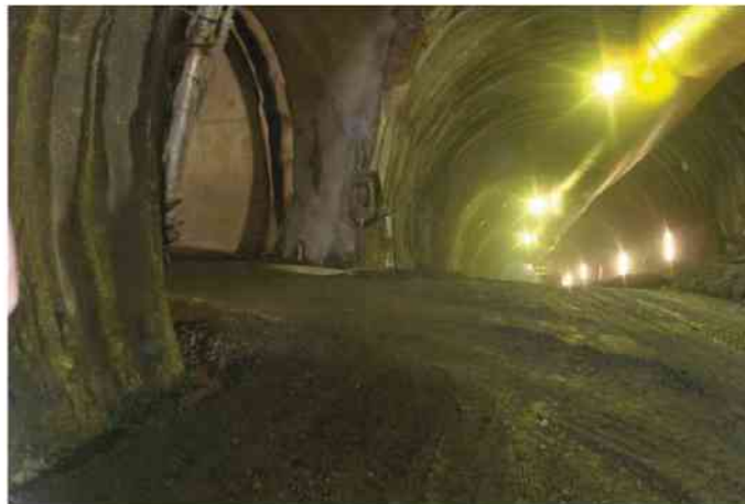
Abb. 5-69: BBT: Abzweigung des Padastertunnels
