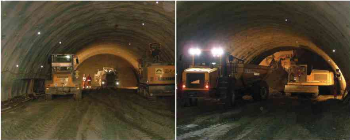
Abb. 6-101: Stein West: Fahrbahn vor der Ortsbrust
