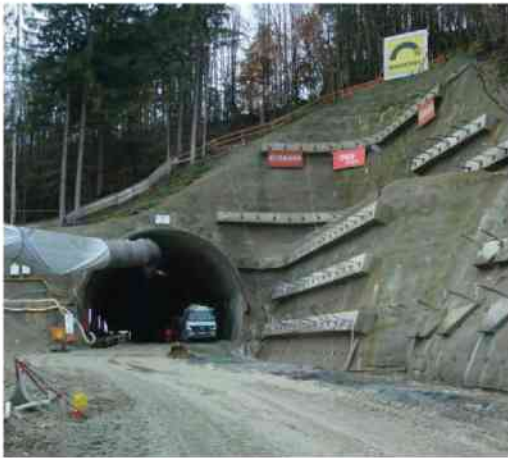
Abb. 6-96: Stein West: Fahrbahn vor dem Portal
