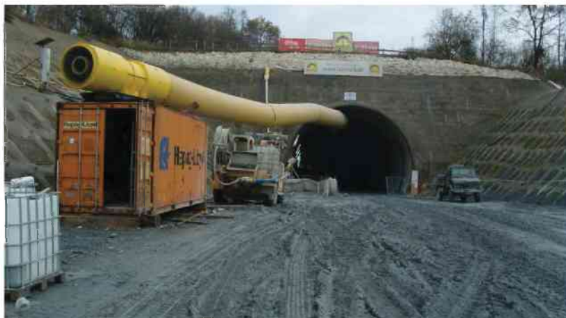
Abb. 6-92: Lind West: Fahrbahn vor dem Portal
