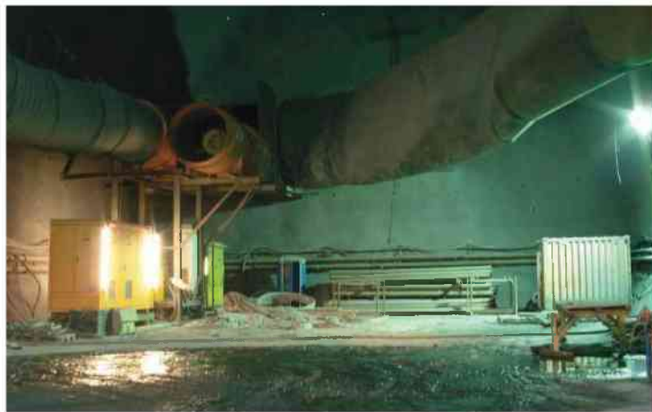
Abb. 5-71: BBT: Kaverne am Ende des Zugangstunnels
