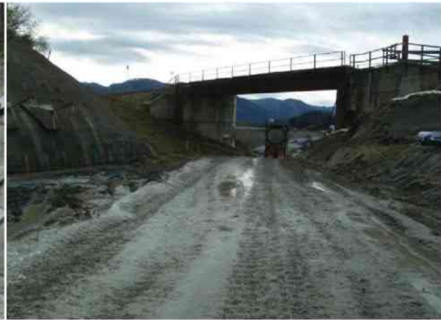
Abb. 6-97: Stein West: Fahrbahn vom Portal aus
