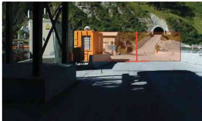
Abb. 5-1: BBT: Messung der Beleuchtung im Portalbereich: Startpunkt
