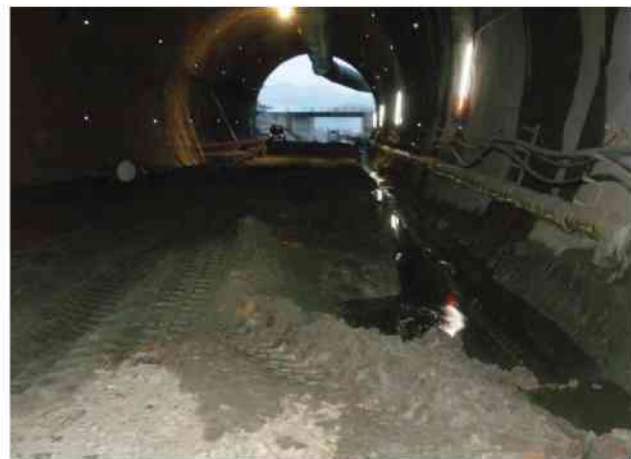
Abb. 6-99: Stein West: Wassergraben
