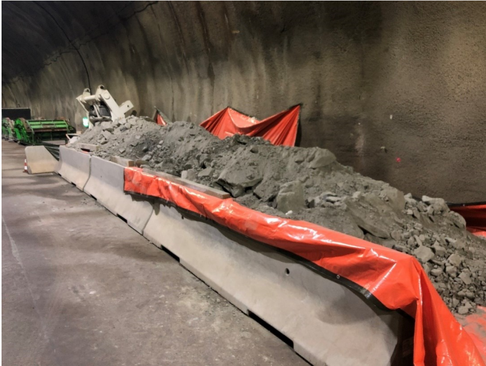
Abbildung 18: Angeliefertes Material aus welchem die Probe für die Versuche entnommen wurden am ZAB Ursprung CERN HL-LHC-Point 1
