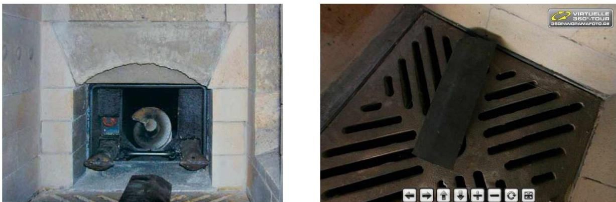
Abbildung 5.4.: Brennraum des HEIZOMAT HSK-RA (links) und Rost mit Ascheräumer (rechts) [125].
