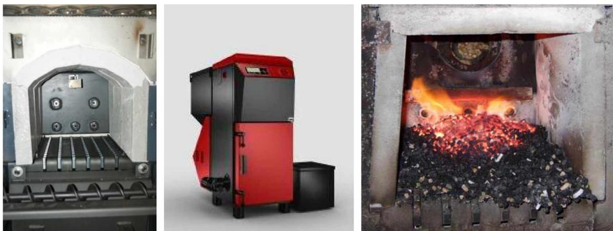
Abbildung 5.14.: Blick in den Brenner (links), VERNER-Kessel (mitte) [147]; Brenner in der Ausbrandphase mit Weizenstrohpellets (rechts).
