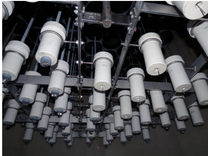
Abbildung 27: Niederschlagselektrodenbündel mit Sprühelektroden 133
