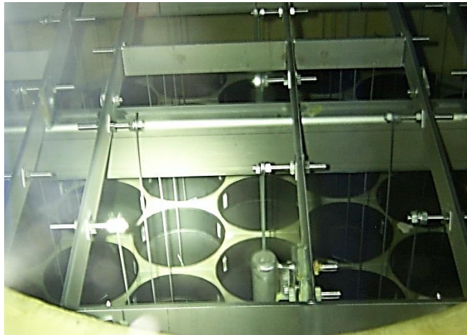
Abbildung 25: Sprühelektrodenaufhängung oberhalb der Abscheidezone
