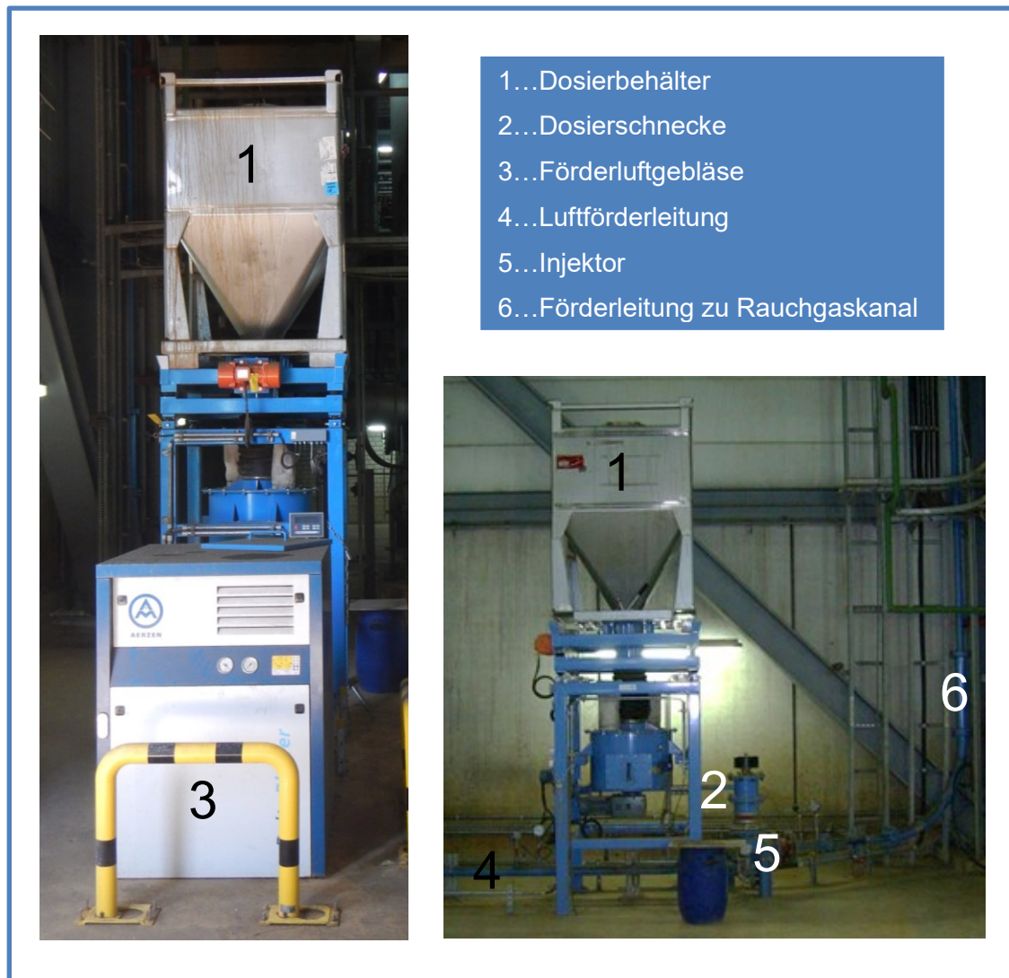
Abbildung 34: Aufbau Staubdosieranlage
