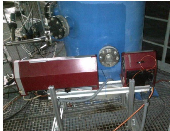
Abbildung 36: Messstelle nach NEF (Reingas)
